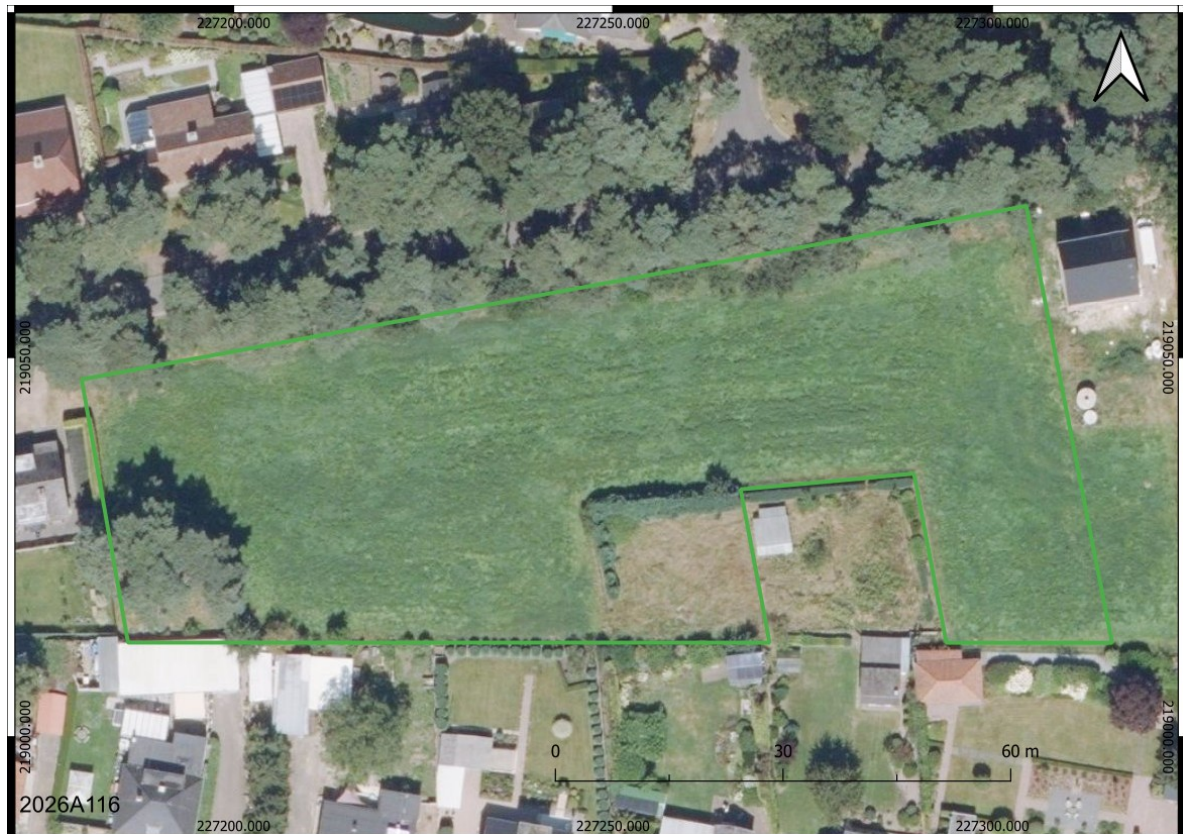
Afbeelding 3.3.1: Luchtfoto bestaande toestand.
