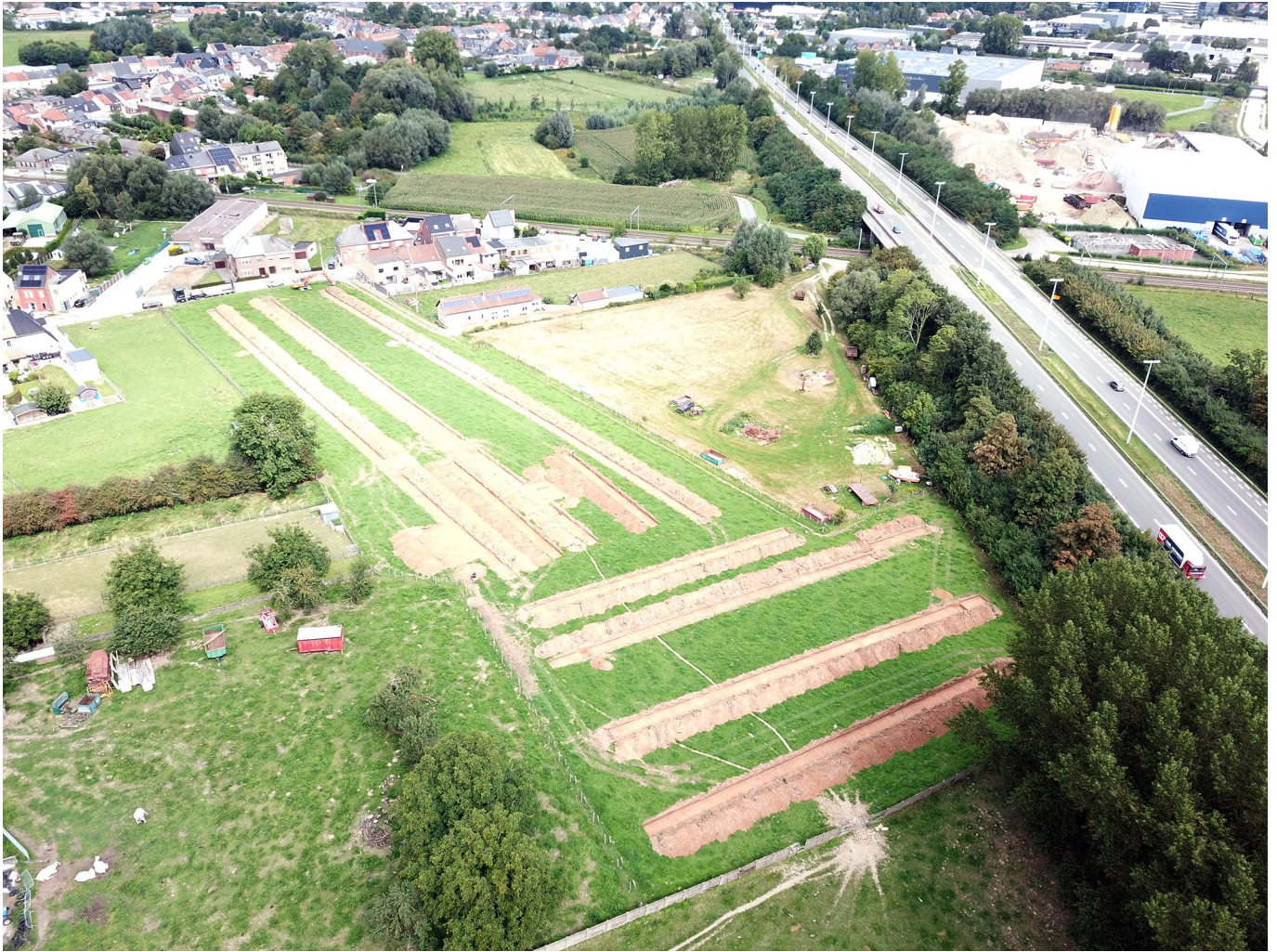
Figuur 3: Zicht vanuit het zuiden op het proefsleuvenonderzoek
