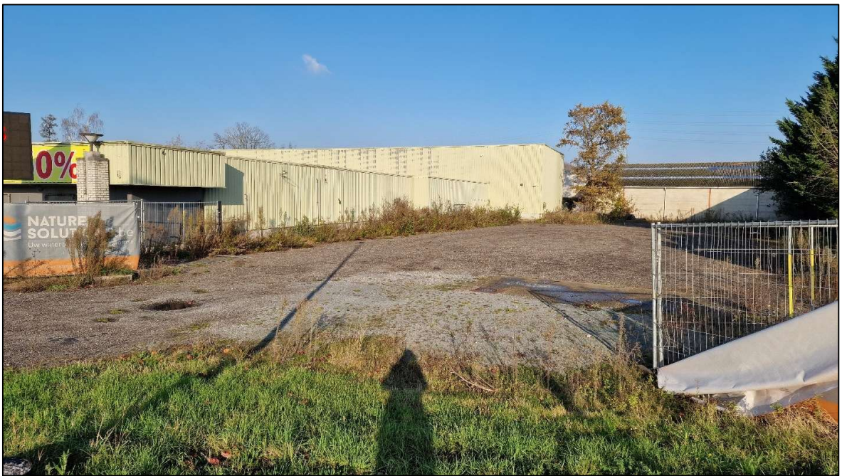
Figuur 12: Zicht op het zuidoostelijke deel van het projectgebied, voormalige garage (gesloopt in 2022) (Initiatiefnemer 2025).
