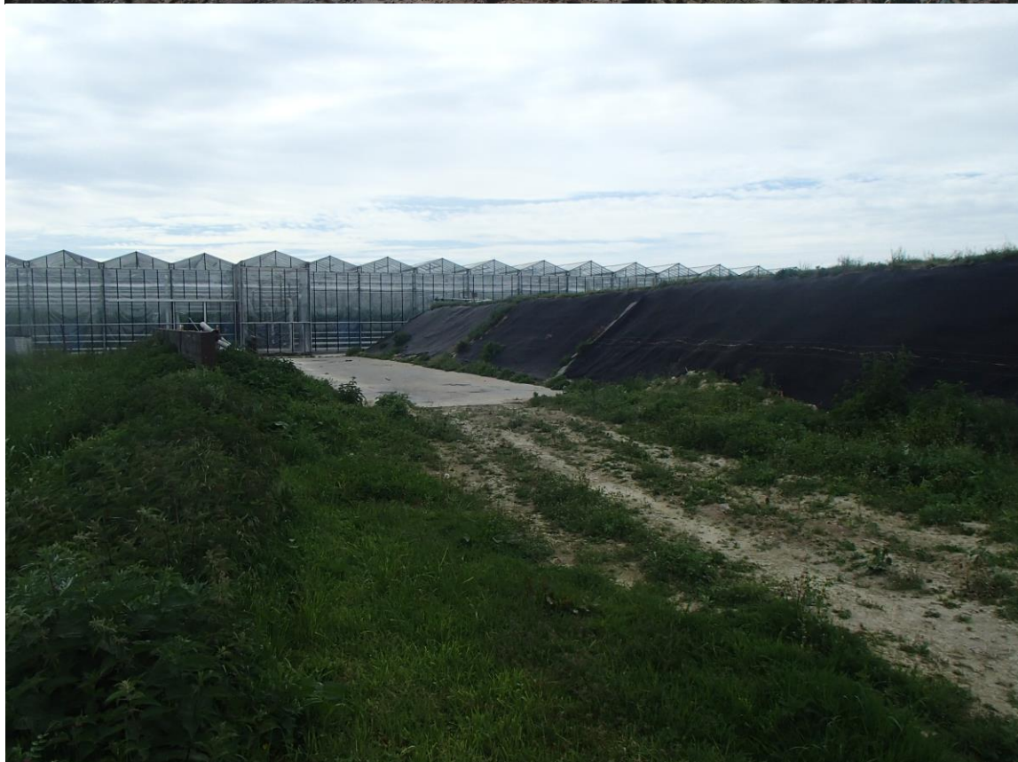
Figuur 5: Aanwezigheid van prei-gewassen en beton waardoor het sleuvenplan ter plaatse aangepast moest worden
