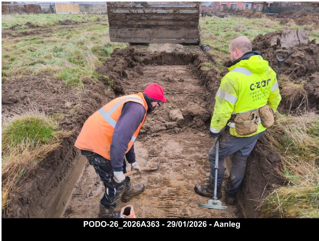
Figuur 10: fotografische opname van de aanleg van een proefsleuf. Voorafgaand worden de graszoden afgenomen en bekeken op munitie.
