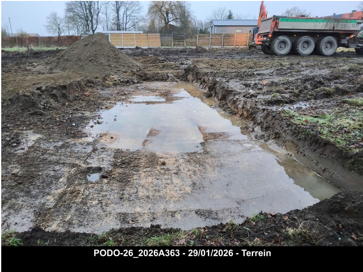
Figuur 35: fotografische opname van het afgegraven koerfragment ten behoeve van de asbest.
