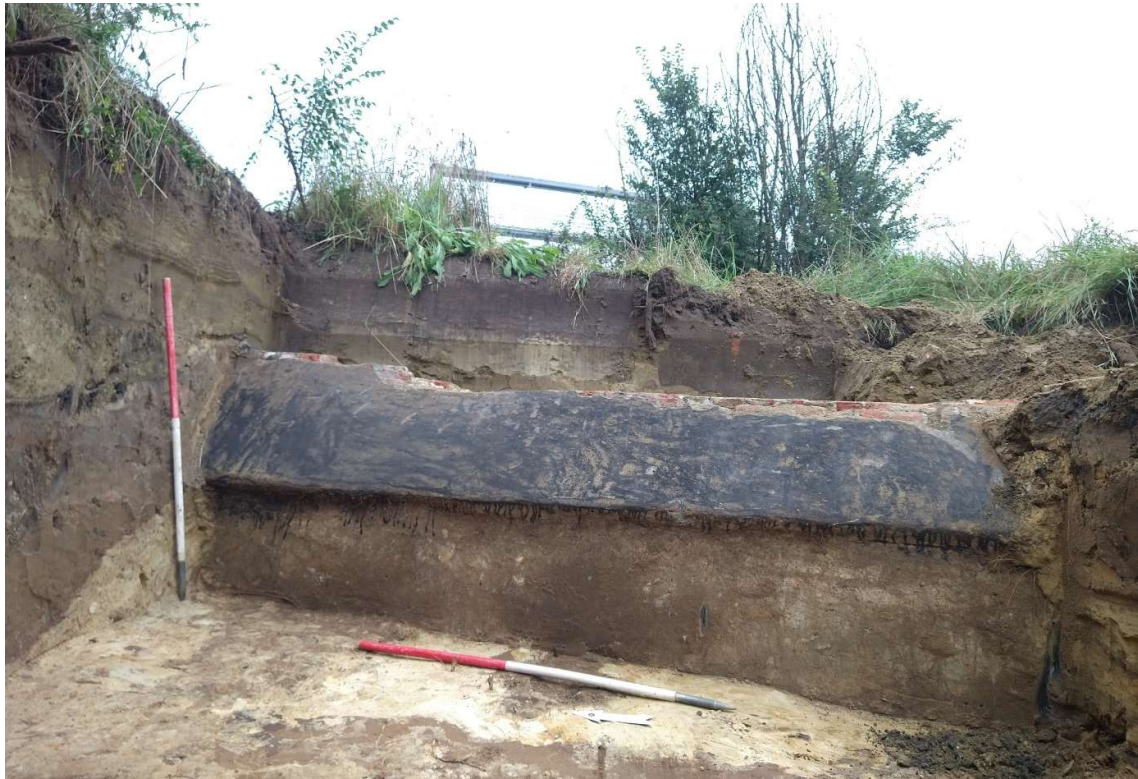
Figuur 93. Gecementeerde en met teer bestreken binnenzijde van S26.
