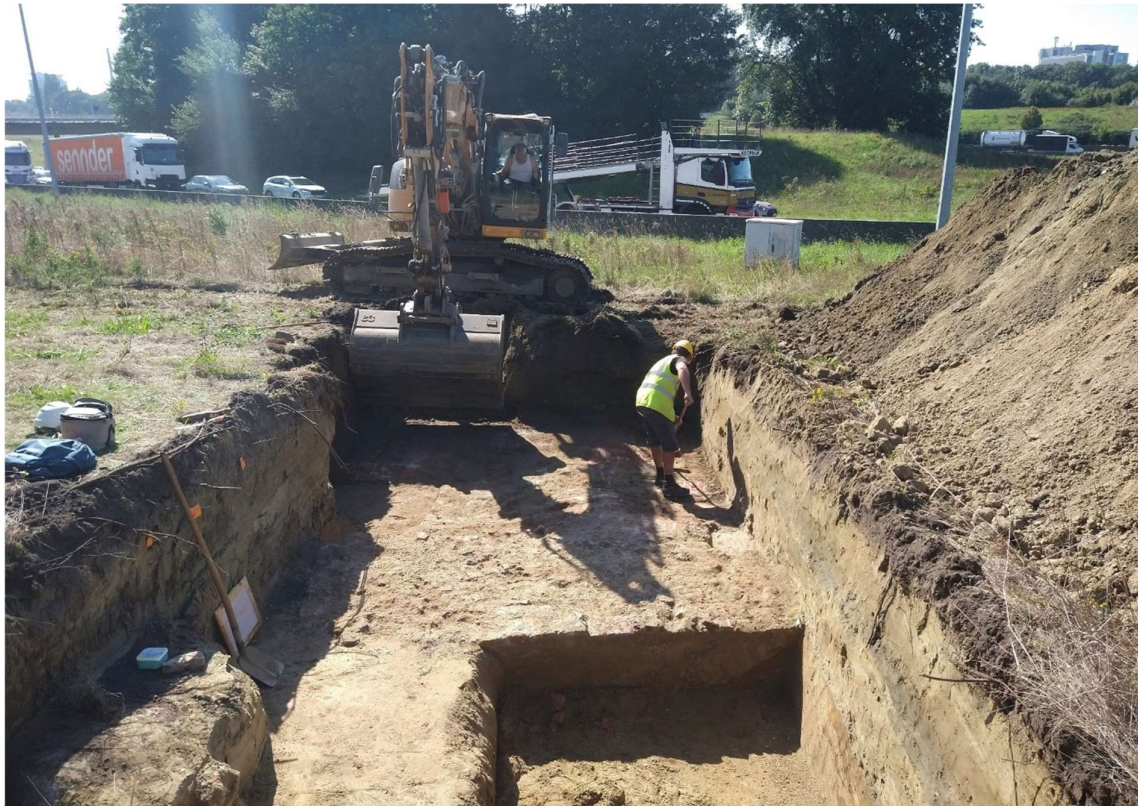
Figuur 81. Aanleg van werkput 4.
