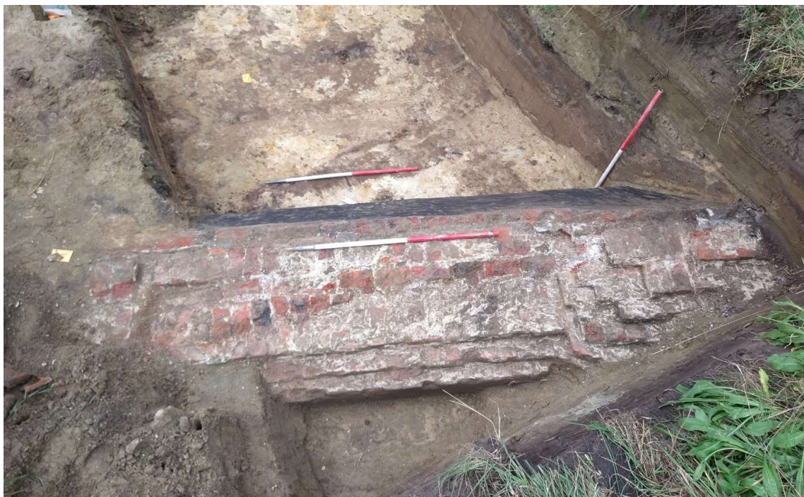
Figuur 94. Bovenaanzicht van de keermuur S26.
