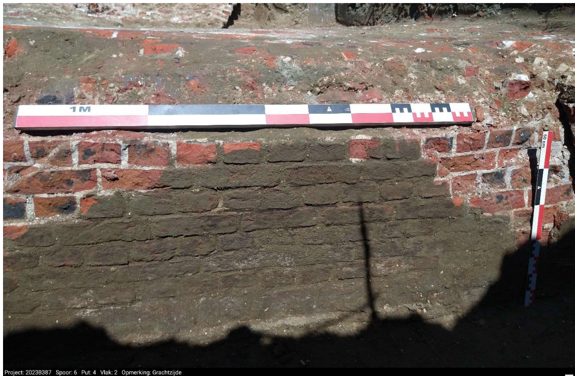
Figuur 112. Detail van het opgaand muurwerk uitgewerkt in kruisverband ter hoogte van het zuidelijke muursegment van S6 (grachtzijde).
