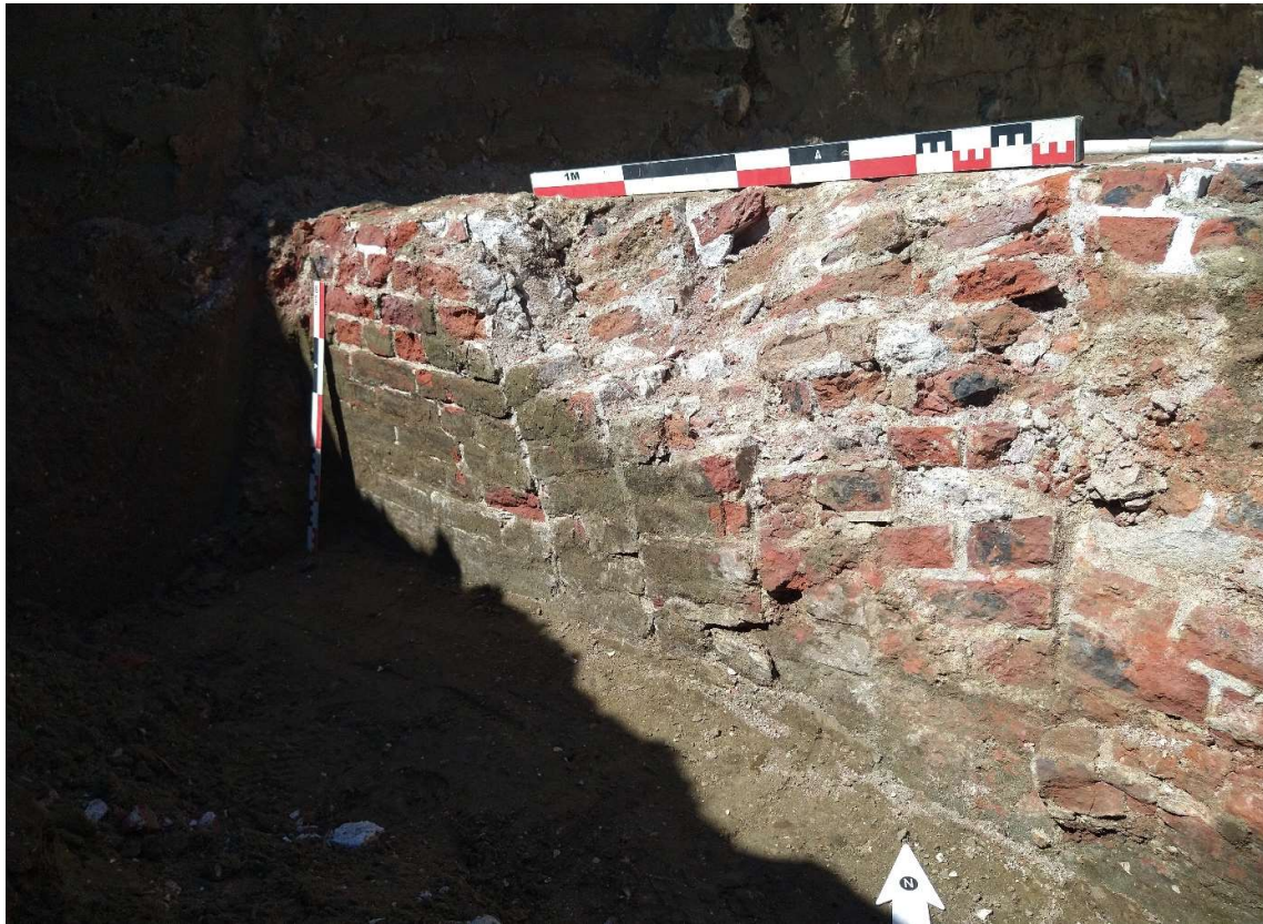
Figuur 113. Detail van de 4 strekken brede boog uitgewerkt in de voorzijde (zuidwestelijke hoek) van de structuur S6.
