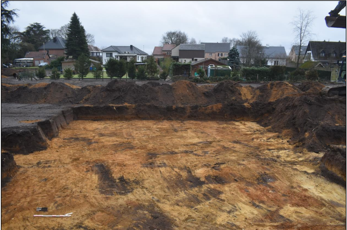
Afb. 52: Vlakfoto kijkvenster 1 (Bron: ARON bv, dd. 11/02/2026, 2026B84).
