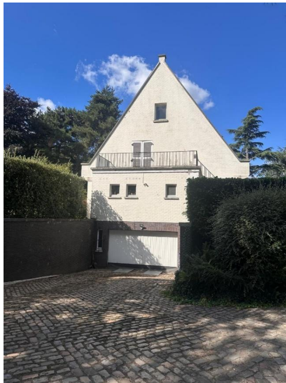
Figuur 3: Huidige situatie: Garage met verdiepte inrit aan de oostelijke zijde van de woning 5
