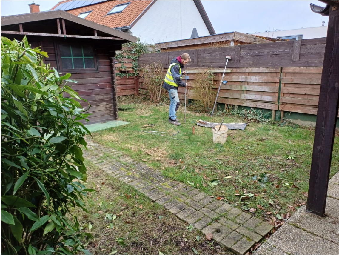
Figuur 29: Uitvoering van de boringen in één van de tuinen
