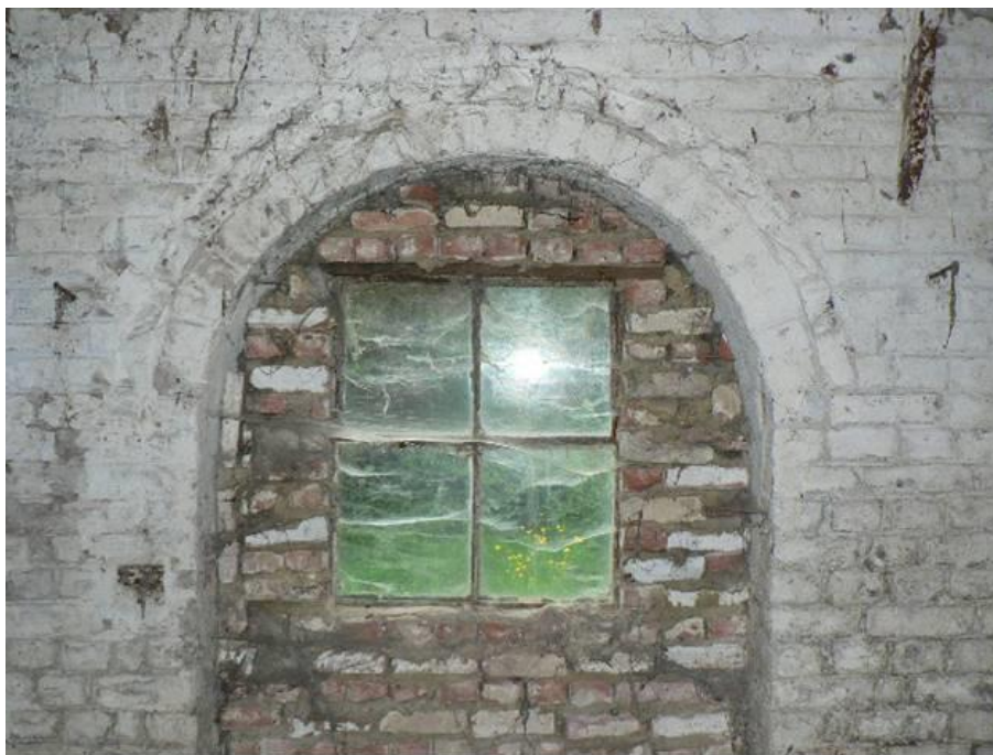
Figuur 25: detailfoto rondboog grote schuur: rondboog is gemetseld met 19 de eeuwse baksteenmaat 21,5x10x5, en in de 20 ste eeuw dichtgemetseld met maat 18x8,5x6,5.
