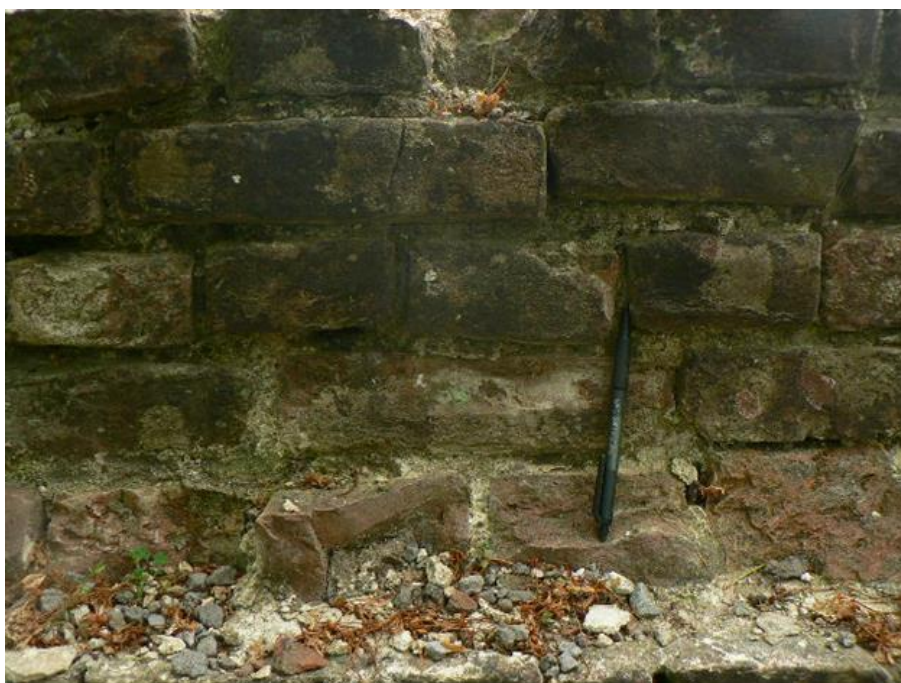
Figuur 28: detailfoto kleine schuur: eerste steenlagen boven maaiveld 18x8,5x6,5
