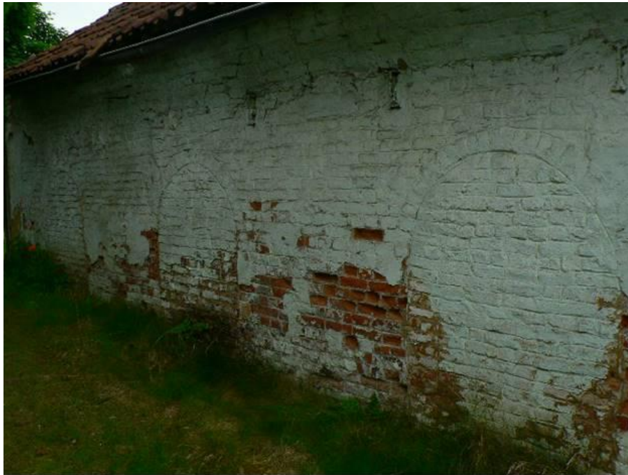
Figuur 24: zuidelijke gevel van grote schuur met rondbogen die wijzen op een gebruik als paardenstal.
