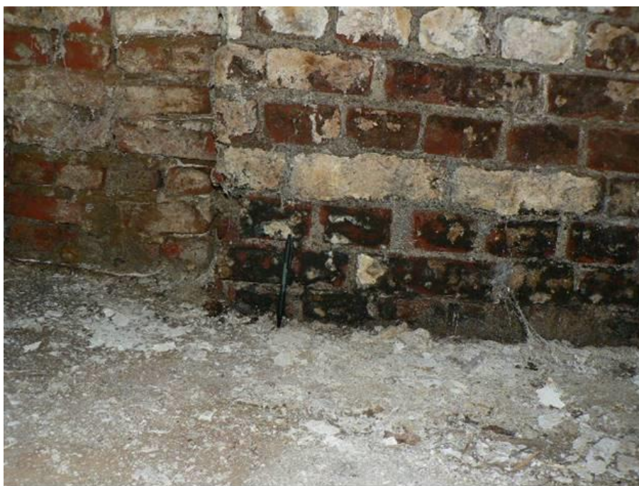
Figuur 26: detailfoto rondboog en parament grote schuur gemetseld met 19de eeuwse baksteenmaat 21,5x10x5.
