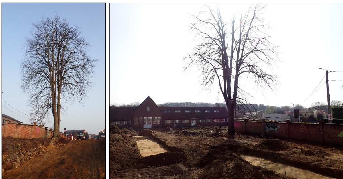
Figuur 26: Te behouden boom in het westen van het terrein en onderbroken WP 6. (©INDAR bv)
