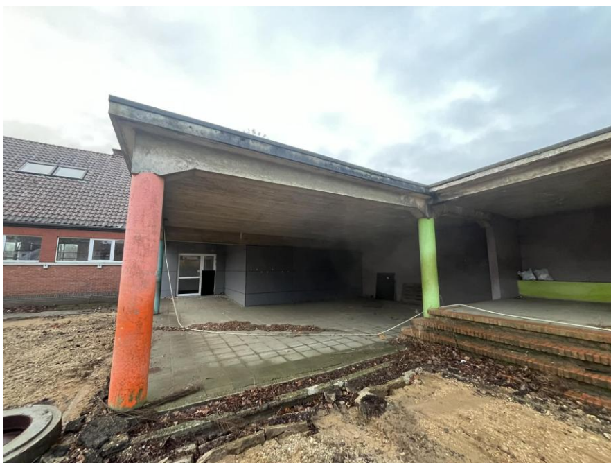
Figuur 20: Foto gebouw ter hoogte van boring 30. (©INDAR bv)
