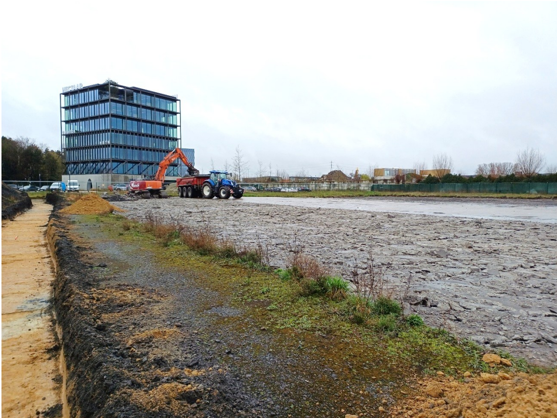
Figuur 18: De betonverharding die alsnog werd uitgebroken tijdens de uitvoering van het proefsleuvenonderzoek zodat hier nog een proefsleuf kon aangelegd worden
