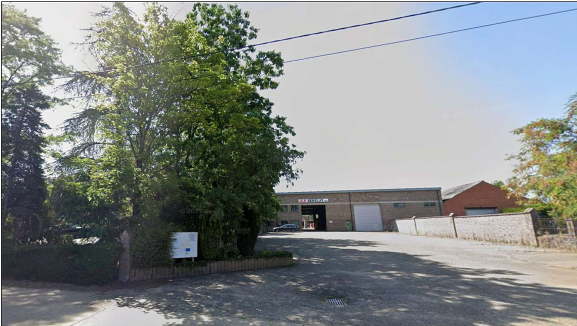
Figuur 4 Zicht op de loods langs de Tessenderloseweg 149 (bron: https://www.google.com/maps ).
