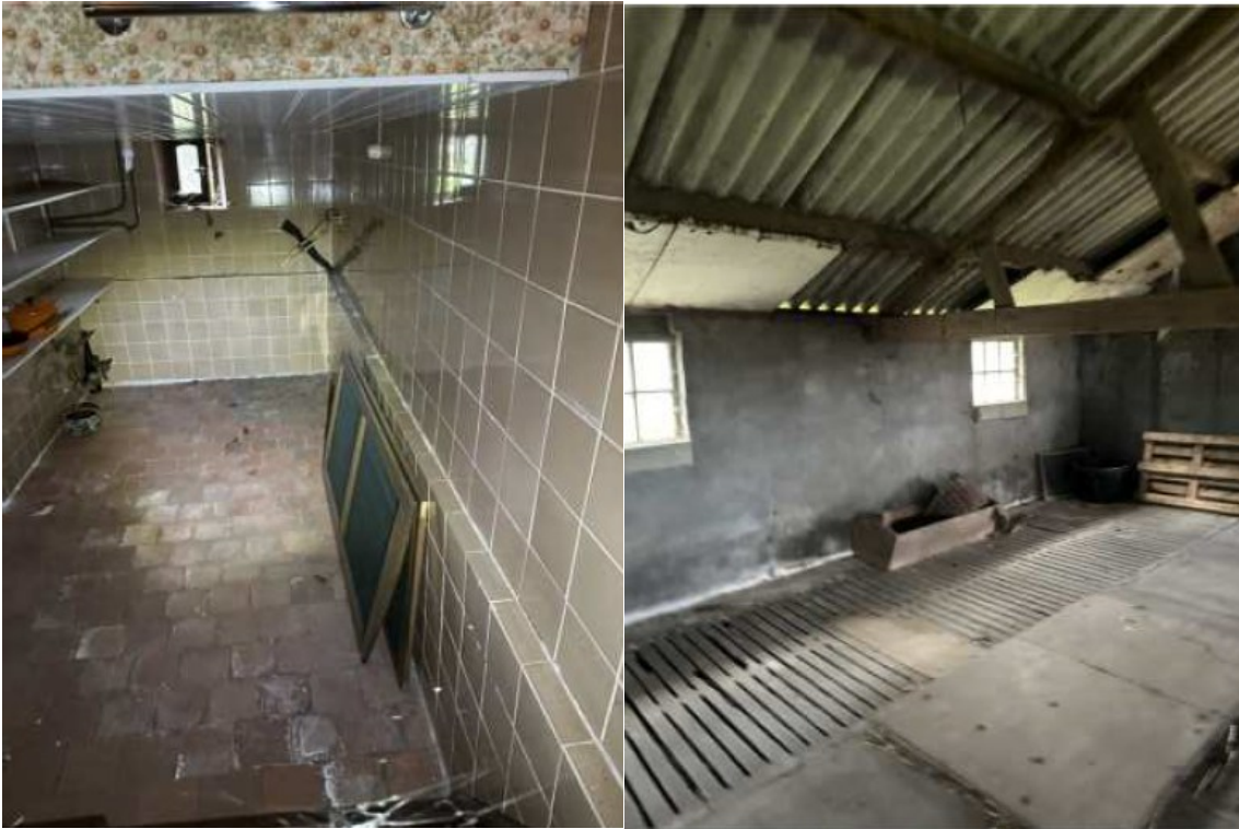
Figuur 3: De kelder onder de woning (links) en de roosters van de mestput onder de stal (rechts)
