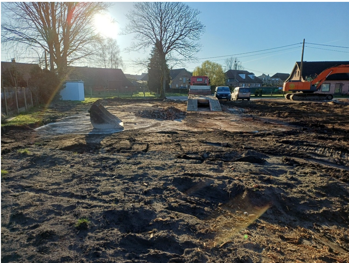
Figuur 22: Zicht op de aanwezige verharding
