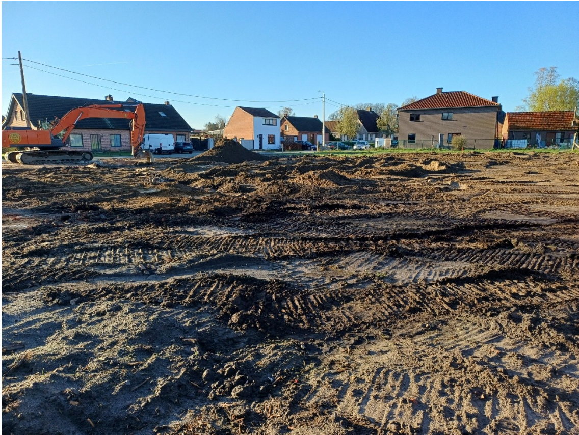
Figuur 21: Zicht op het terrein bij aanvang van het proefsleuvenonderzoek
