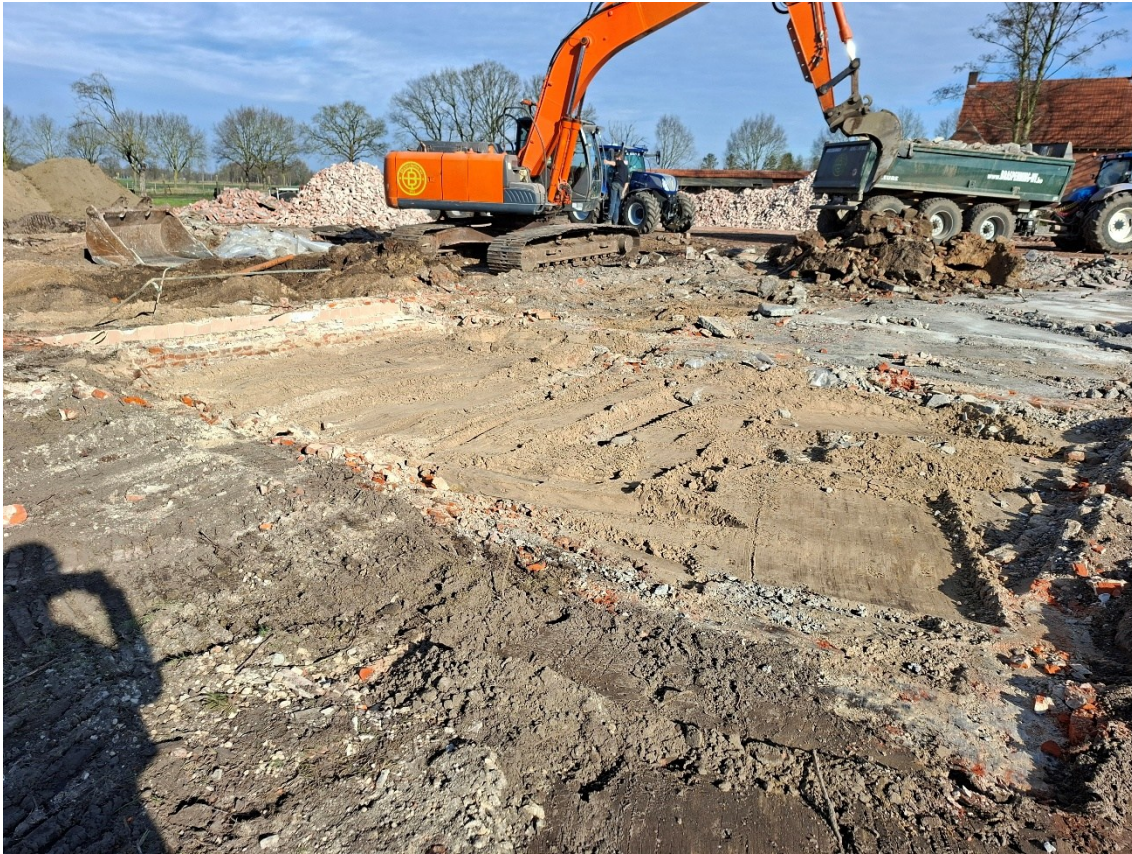
Figuur 20: Funderingen van de bebouwing aan de straatzijde
