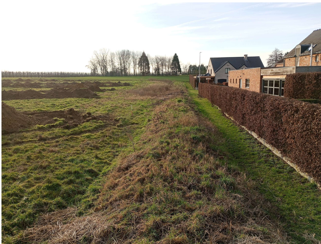
Fig. 2.8: Zicht op de aarden dijk aan de westelijke zijde van het terrein.
