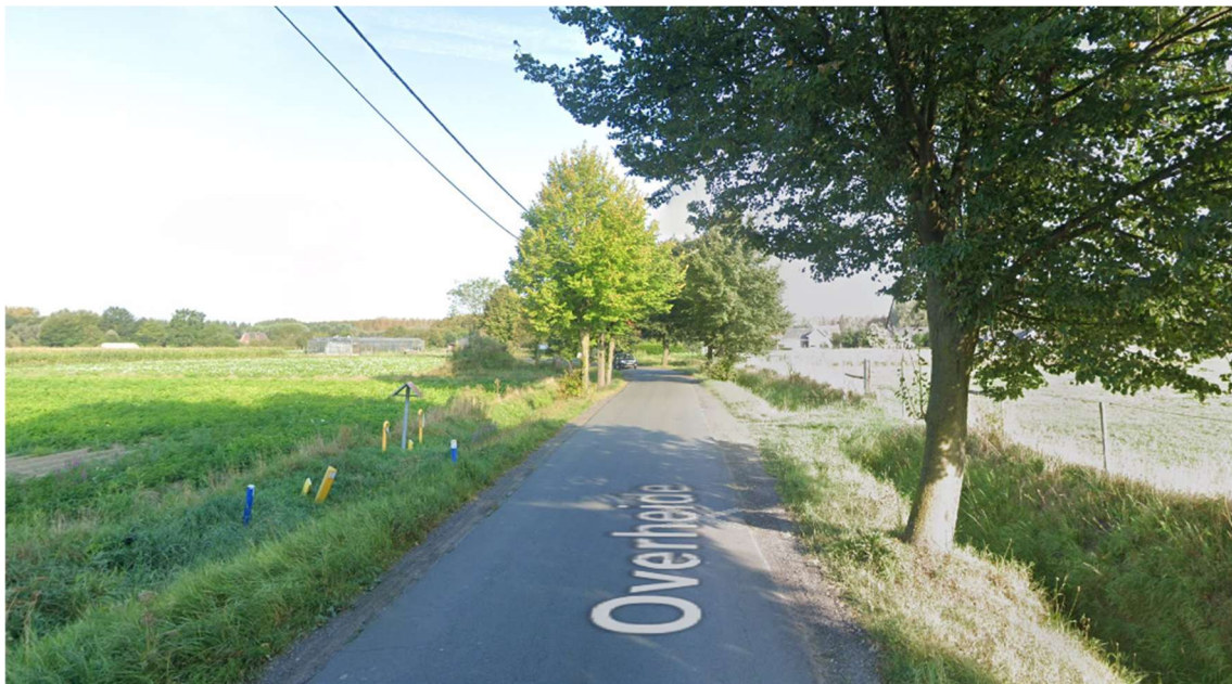
Fig. 1.12: Huidige toestand Overheide met links nutsleidingen en rechts open grachten (© Google Streetview, opname september 2024).
