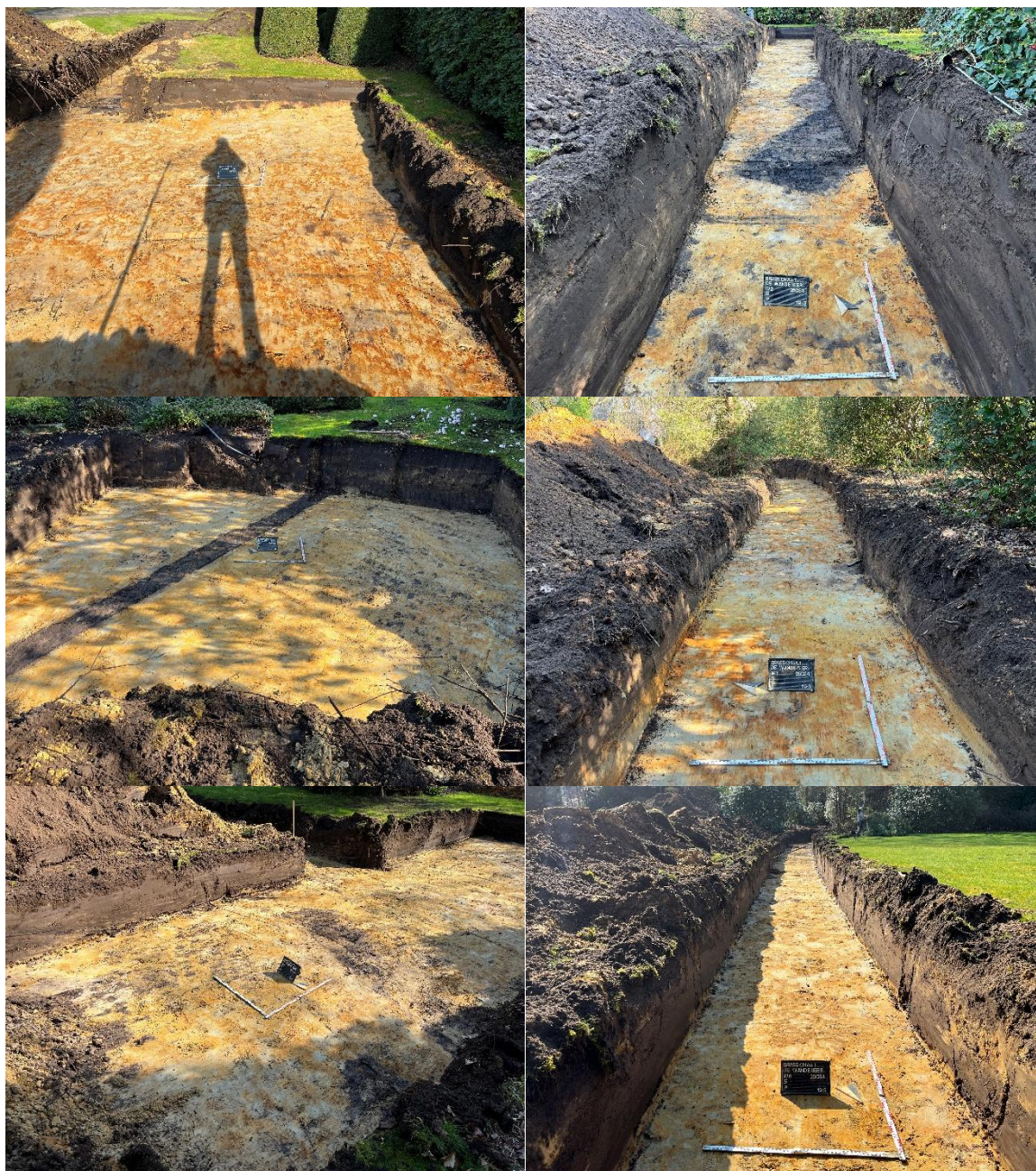
Figuur 16: Overzichtsfoto's werkputten en kijkvensters (© INDAR bv)
