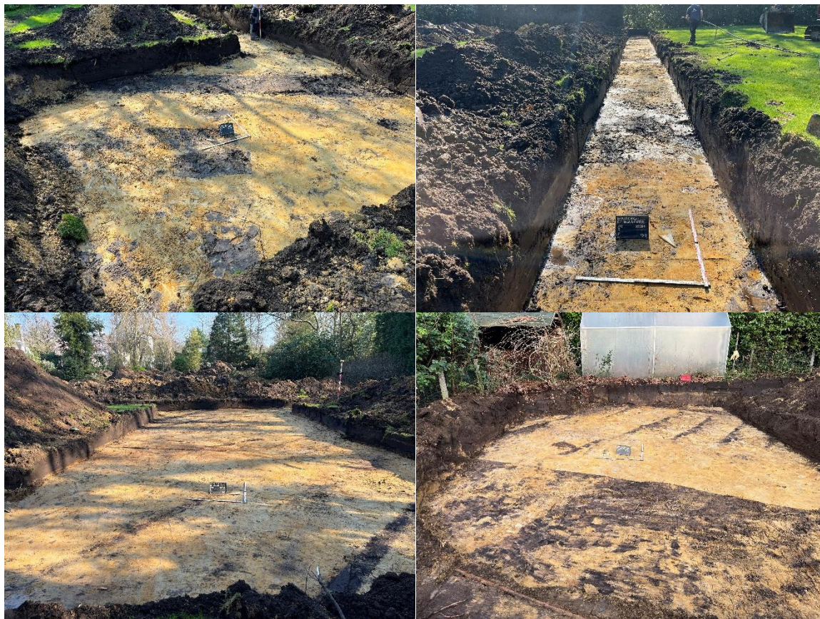
Figuur 17: Overzichtsfoto's werkputten en kijkvensters (© INDAR bv)
