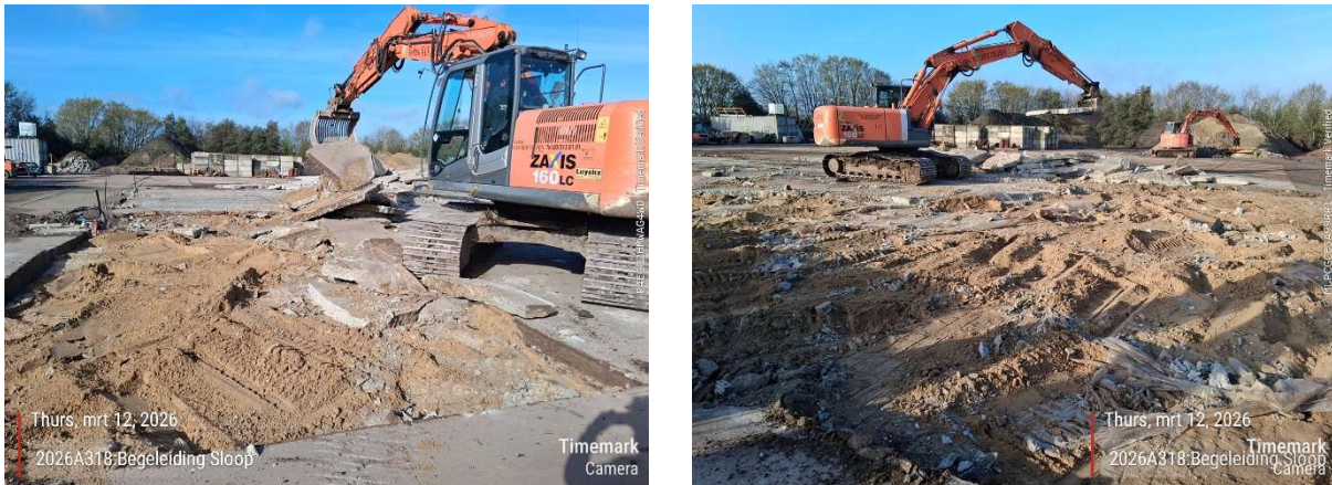
Figuur 12. Enkele foto's genomen tijdens de sloop van de betonverharding t.h.v. zone 1.
