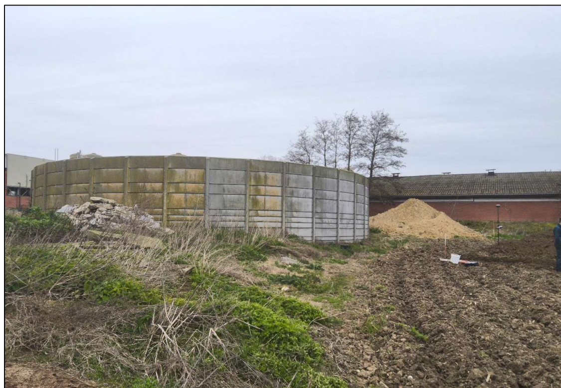
Figuur 4: Ontoegankelijke zuidwestelijke hoek van het onderzoeksgebied.
