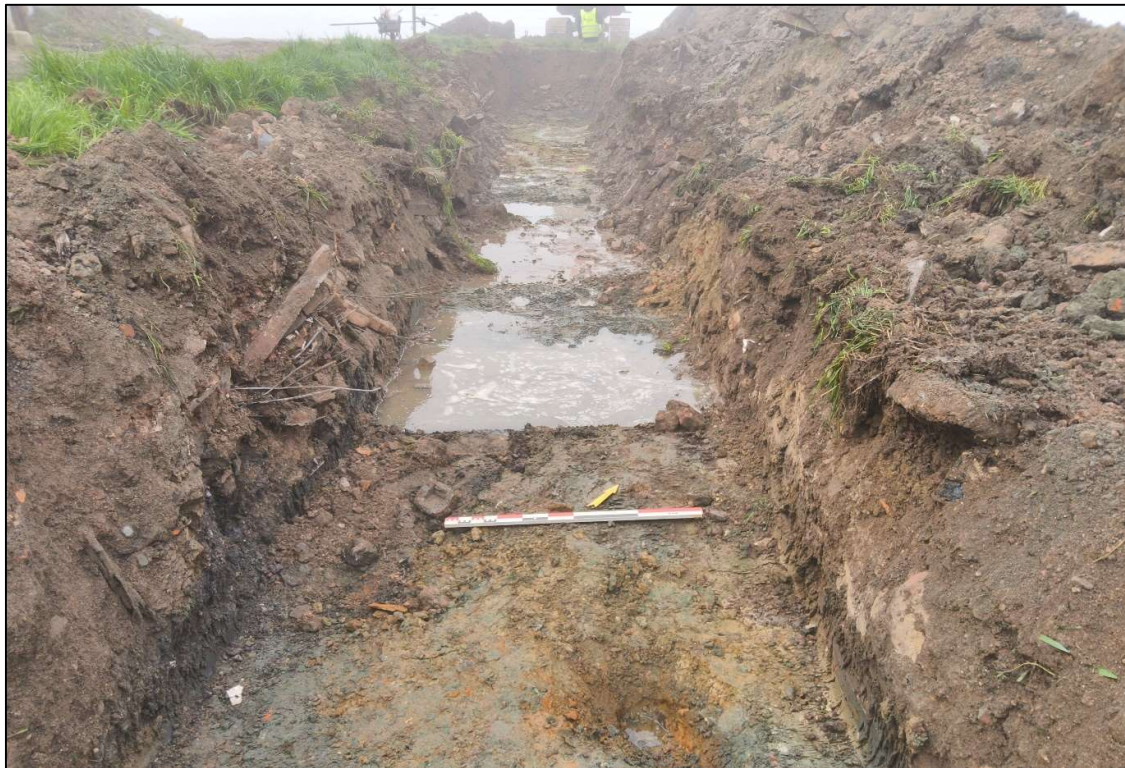
Figuur 24: Sleuf 1 met op de voorgrond de vondstlocatie van de Duitse 150 mm artilleriegranaat en daarachter de met betonpuin opgevulde bovenkant van de oude walgracht.
