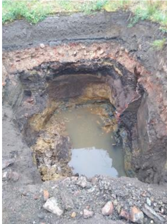
Figuur 44: grondwater in profielput 2
