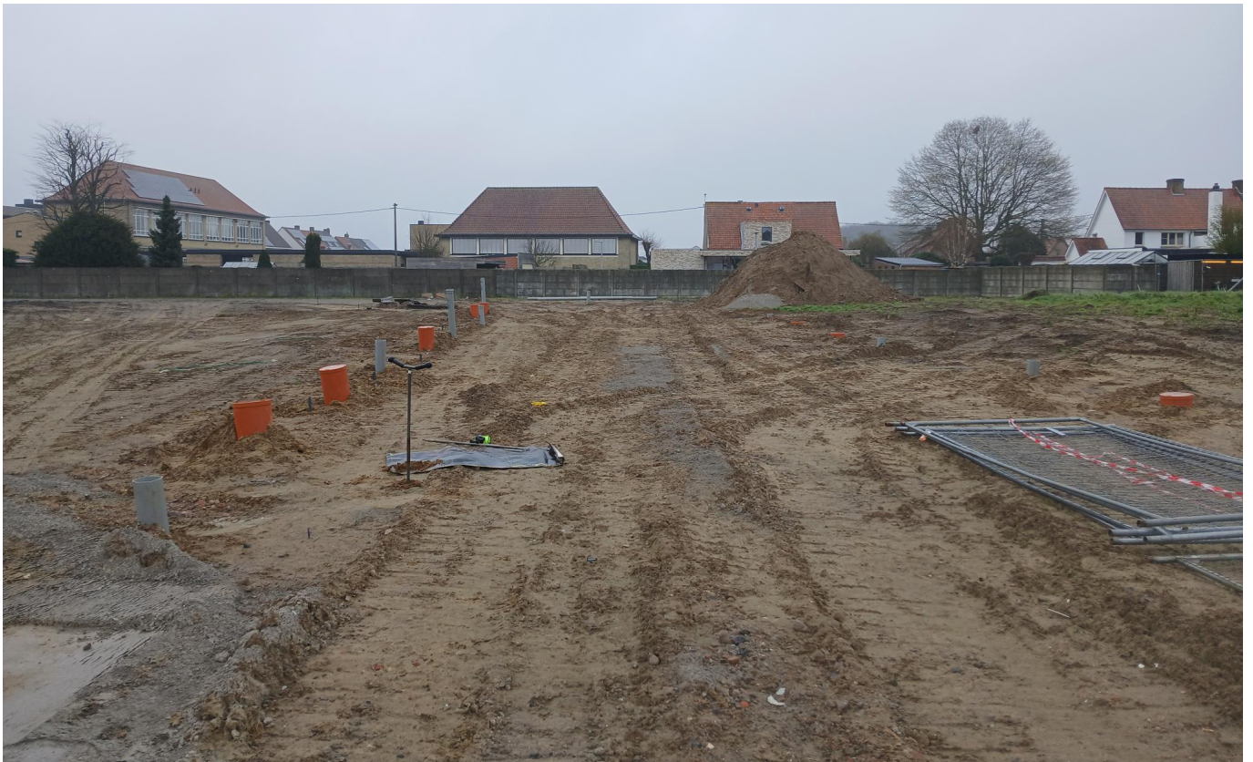
Figuur 6: Uitgekofferde zone met reeds aanwezige nieuwe nutsleidingen. Zicht op zone van boring 3.
