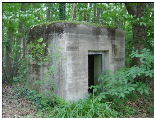
Figuur 22: voorbeeld van een connectiekamer op de KW-linie (kwlinie.be) 8
