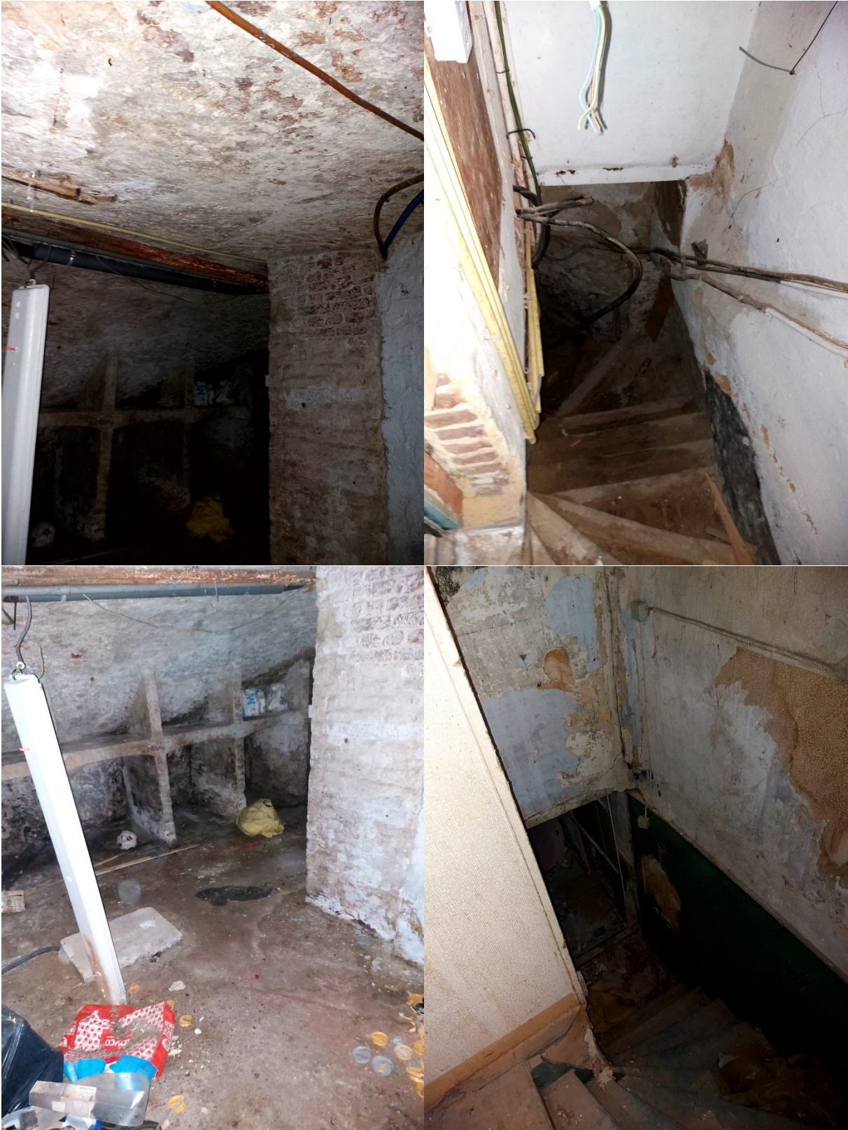
Figuur 3: Foto's bestaande kelders
