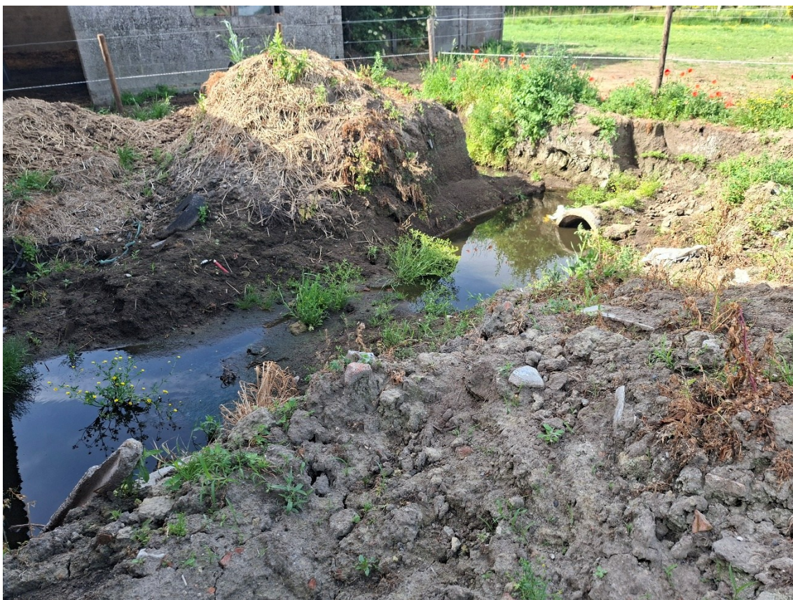
Figuur 6: Reeds aanwezige uitgraving achter de bebouwing in het westen, in functie van afwatering
