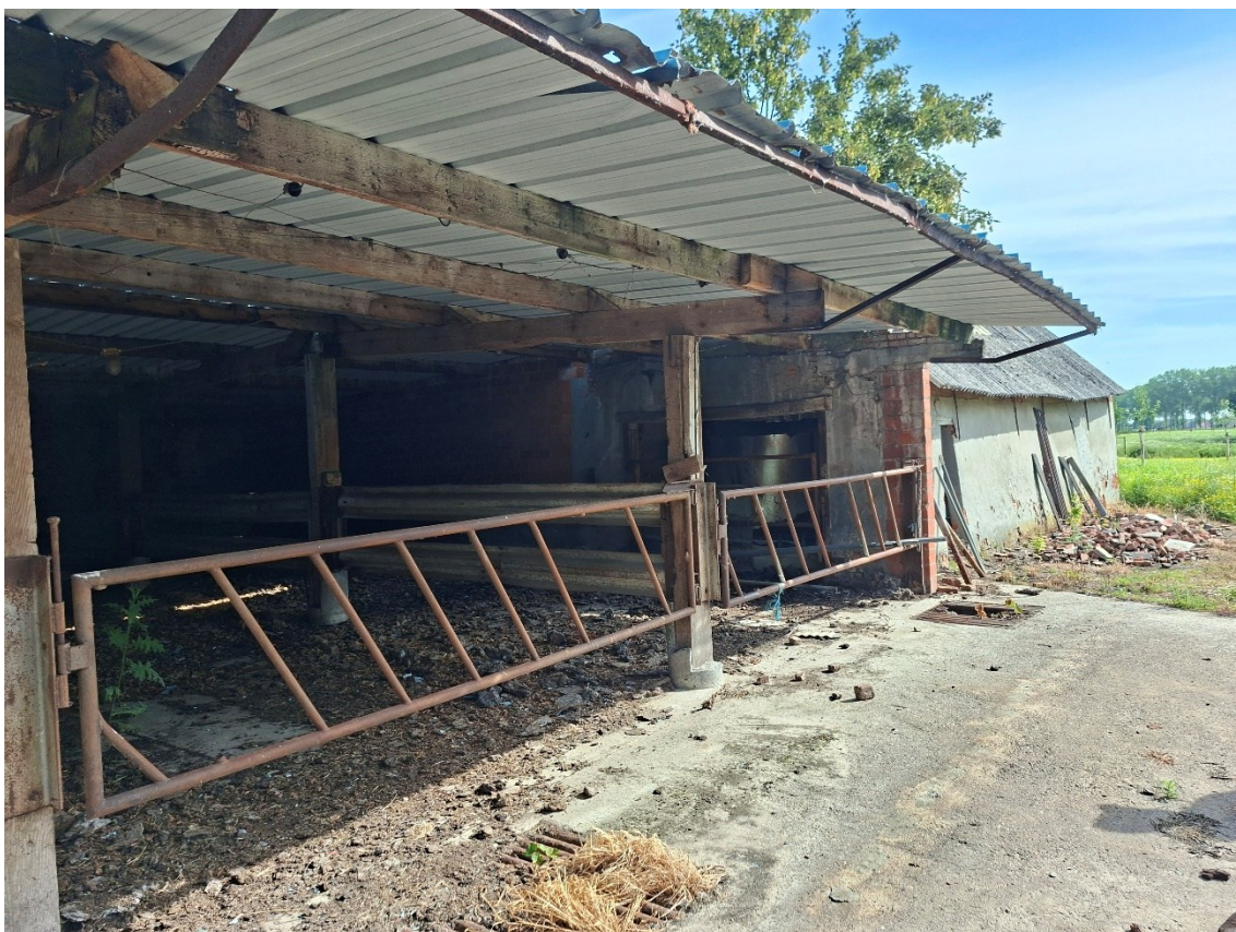
Figuur 5: Zicht op de te slopen bebouwing
