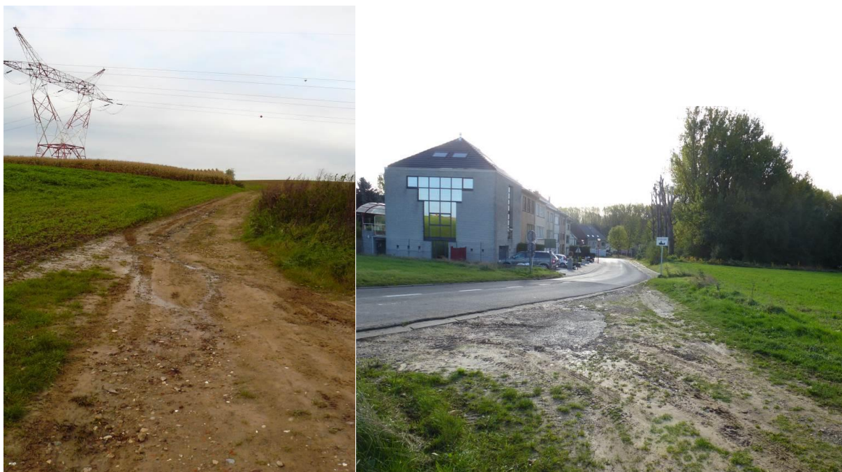
Figuur 21: veldweg (aftakking Sparrenlaan) (links) en zone waar erosiepoel wordt aangelegd (rechts) t.h.v. knelpunt 1 (zone 1) (foto's Provincie Vlaams-Brabant)
