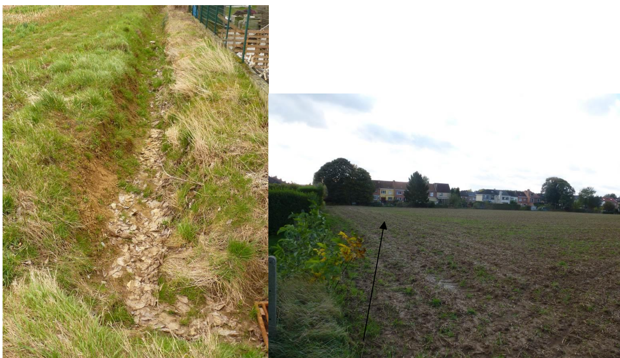
Figuur 22: gracht t.h.v. knelpunt 2 – aansluiting op RWA aan Sparrenlaan (links) (zone 2a) en zone waar erosiepoel wordt aangelegd in knelpunt 2 (rechts) (zone 2b) (foto's Provincie Vlaams-Brabant)
