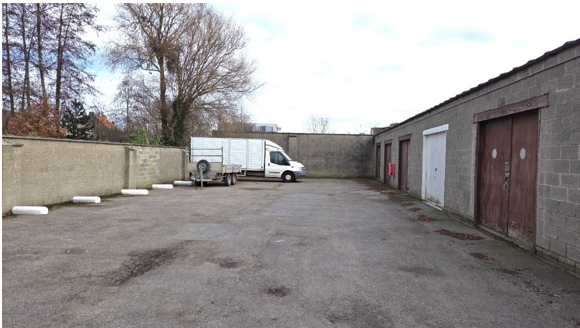
Figuur 3: Zicht op het terrein
