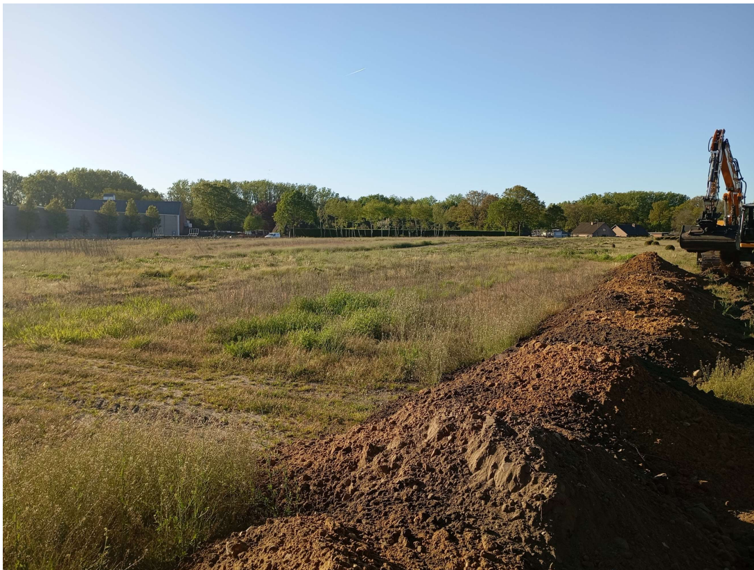
Fig. 3.7: Zicht op het terrein vanuit het noorden richting het zuiden.
