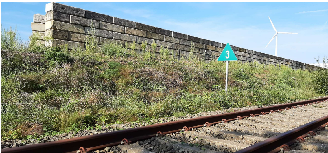
Fig. 1.15: Foto met aanzicht van de muur met betonnen stapelblokken vanaf het spoor (achterkant terrein), Europark 101 (© initiatiefnemer).
