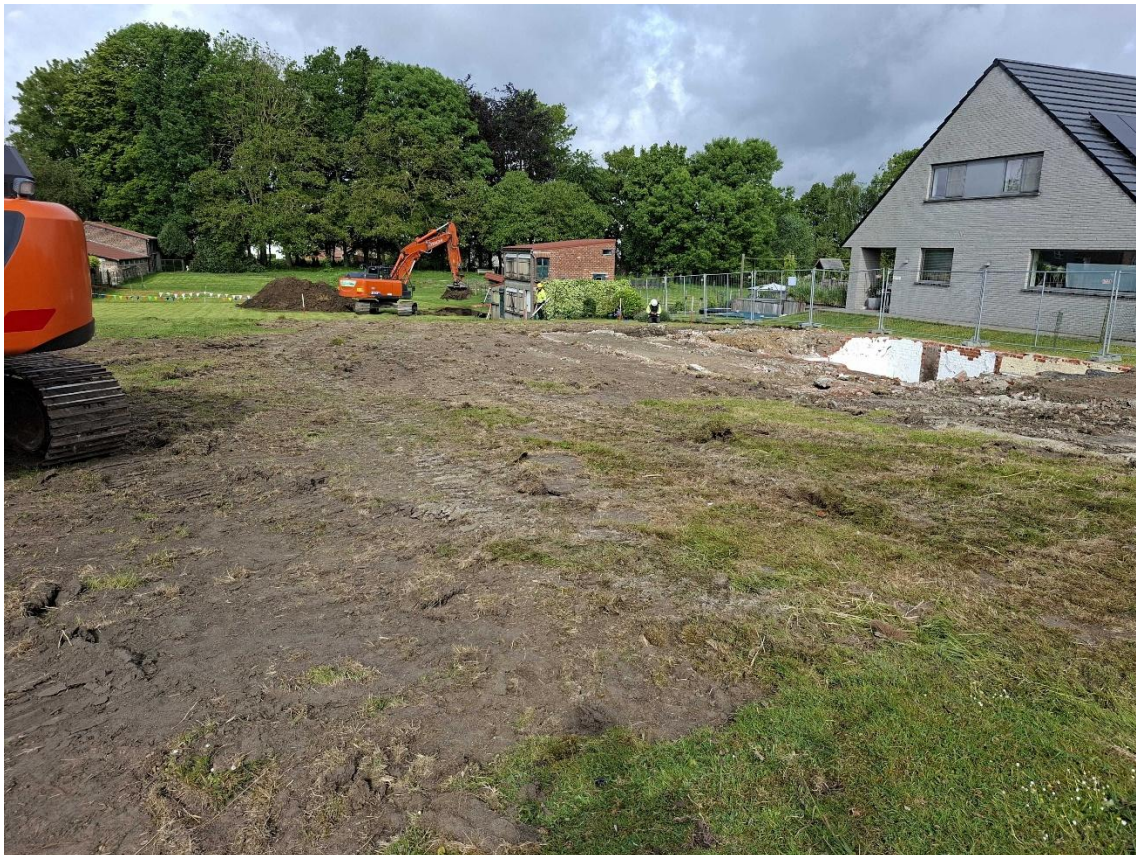
Figuur 3: Terreinfoto getrokken vanuit het oosten met zicht op de gesloopte woning en de tuinberging achteraan.
