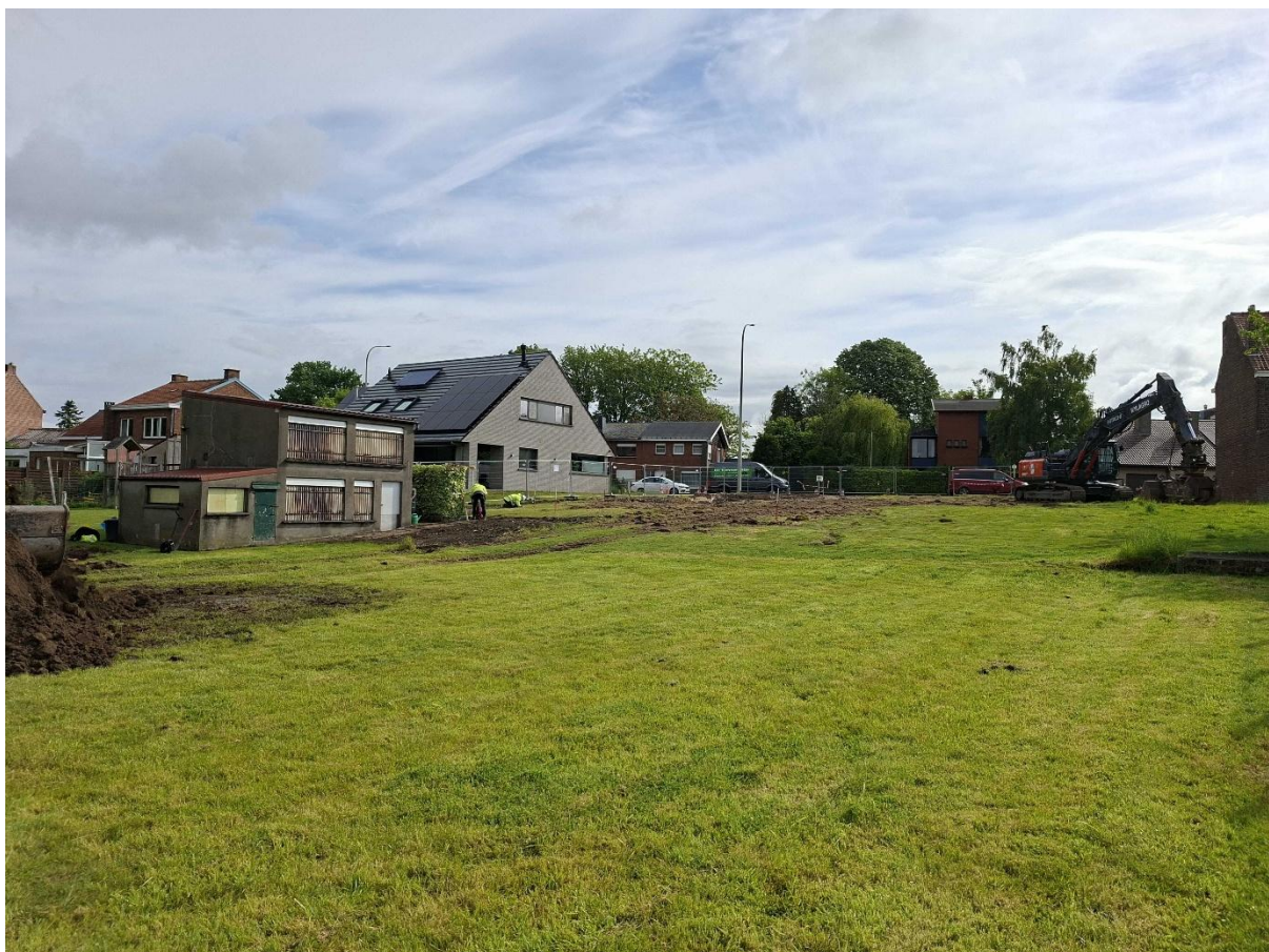
Figuur 4: Terreinfooto getrokken vanuit het zuidwesten met zicht op de tuin en tuinberging links.
