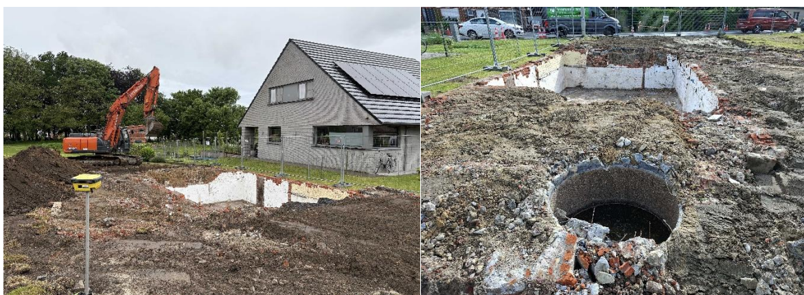
Figuur 5: Zicht op de kelder en de waterput.
