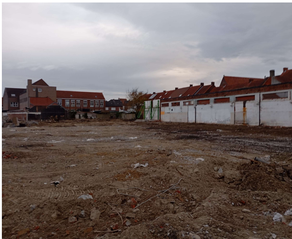
Fig. 3.8: Zicht op het terrein in de zuidelijke zone, in noordelijke richting.
