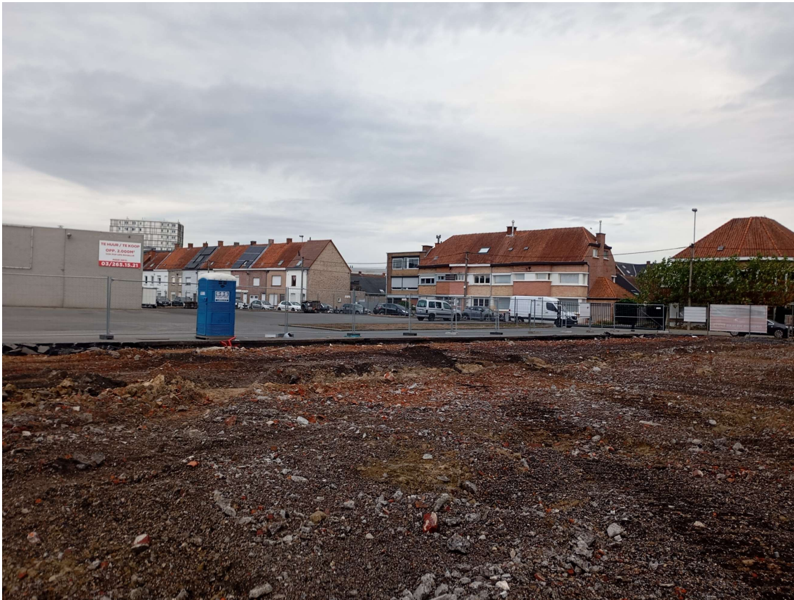
Fig. 3.12: Zicht op noordwestelijke hoek.
