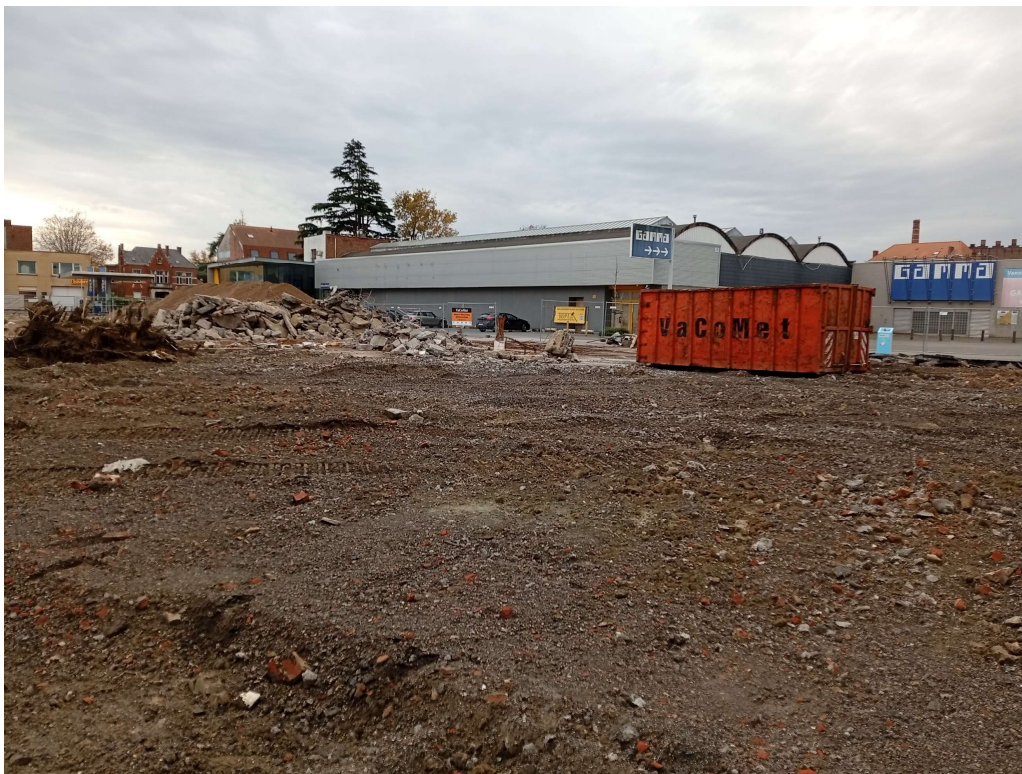
Fig. 3.13: Zicht op de container en puinhoop ter hoogte van WP3, in westelijke richting.
