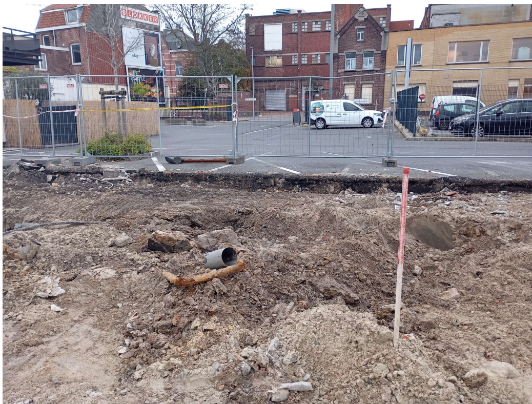
Fig. 3.11: Zicht op de zuidelijke projectgrens.
