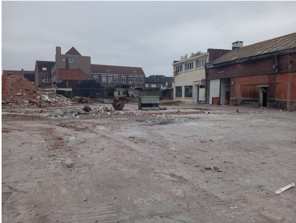
Fig. 2.8: Overzichtsfoto van het terrein in noordelijke richting met de centrale betonplaat
