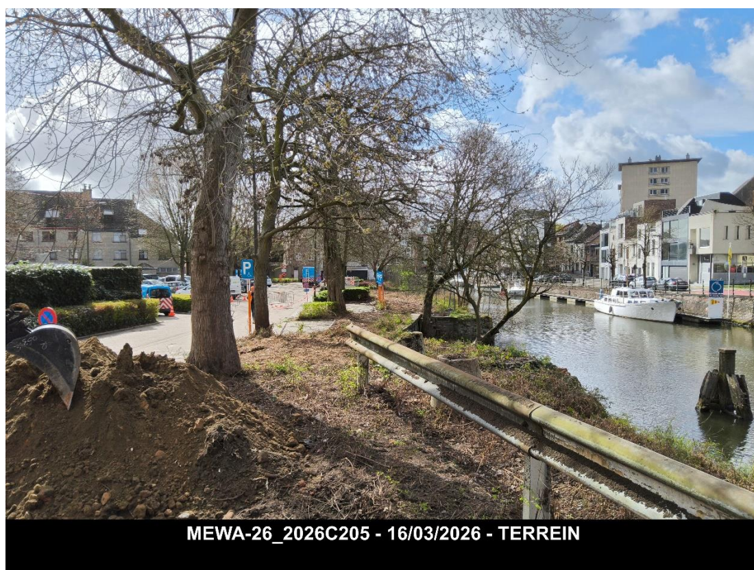
Figuur 8: Terreinsituatie voor aanvang proefsleuvenonderzoek ter hoogte van WP1 met zicht op een te behouden boom.
