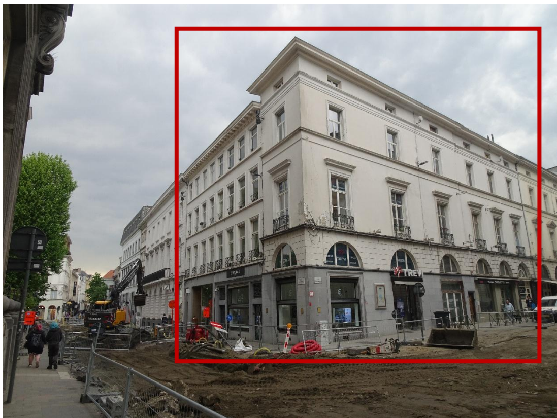
Figuur 7: Zicht op het Koophandelsplein vanuit het zuidwesten met aanduiding van het projectgebied (Hofke ter Musse 2026)
