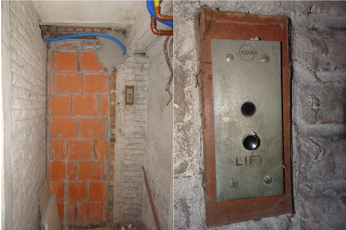
Figuur 20: Dicht gemetselde liftkoker uit 1946 (Hofke ter Musse 2026)
