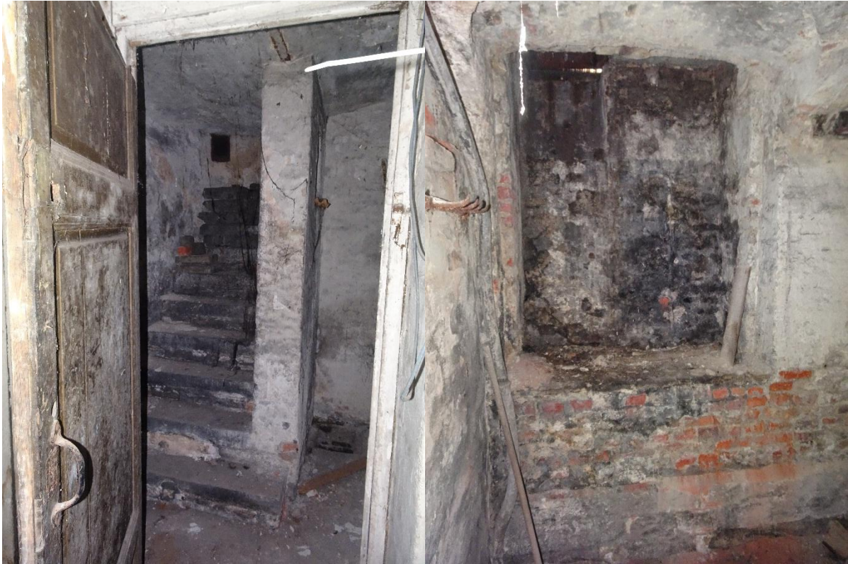
Figuur 15: Zicht op kelder 1 (Hofke ter Musse 2026)
