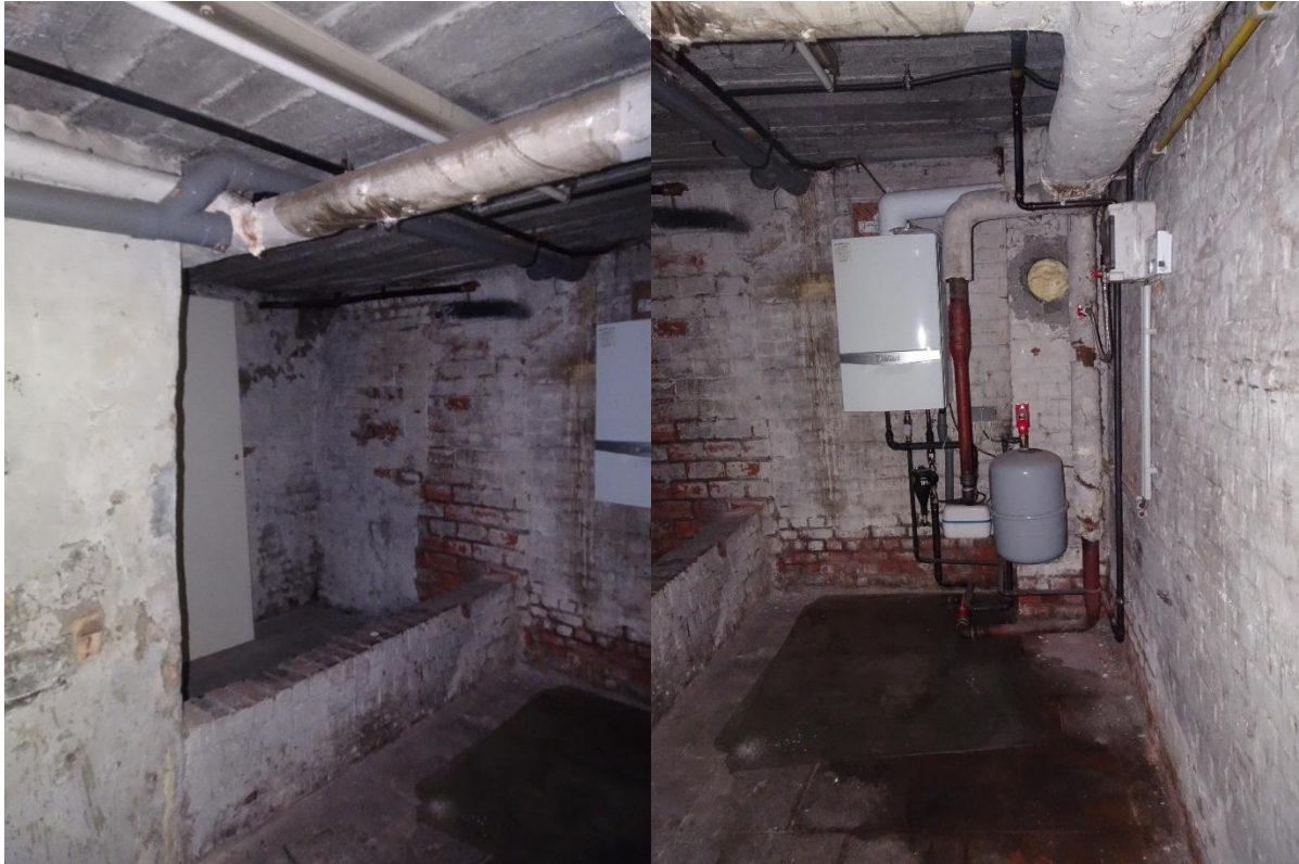
Figuur 27: Zicht op kelder 5 (Hofke ter Musse 2026)
