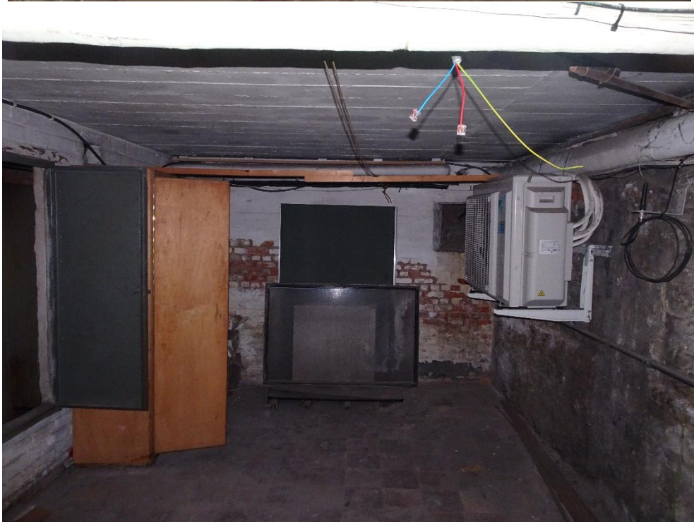
Figuur 29: Zicht op kelder 6 (Hofke ter Musse 2026)
