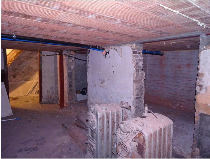
Figuur 18: Zicht op kelder 2 (Hofke ter Musse 2026)
