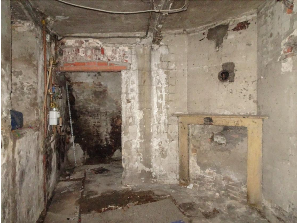
Figuur 24: Zicht op kelder 3 (Hofke ter Musse 2026)
