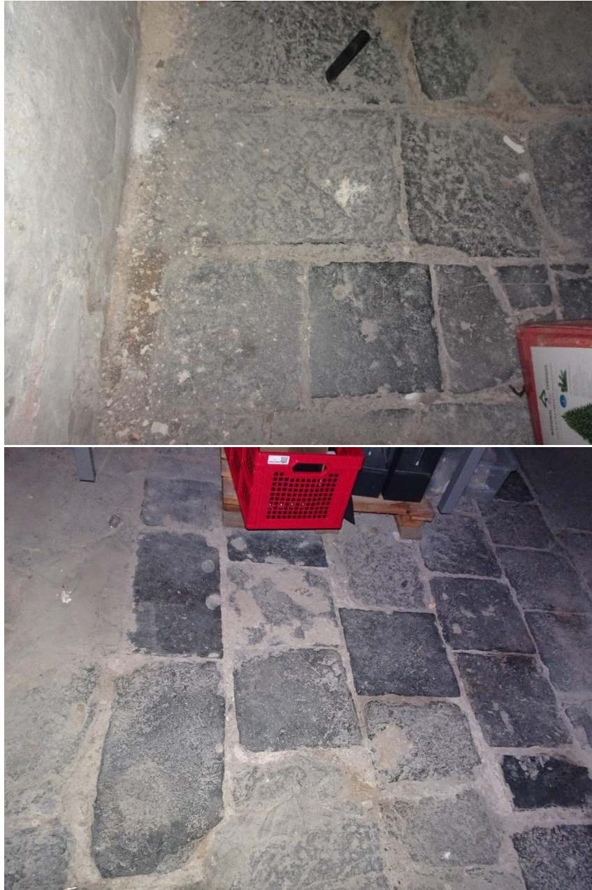
Figuur 17: Vloertegels in Doornikse kalksteen (Hofke ter Musse 2026)
