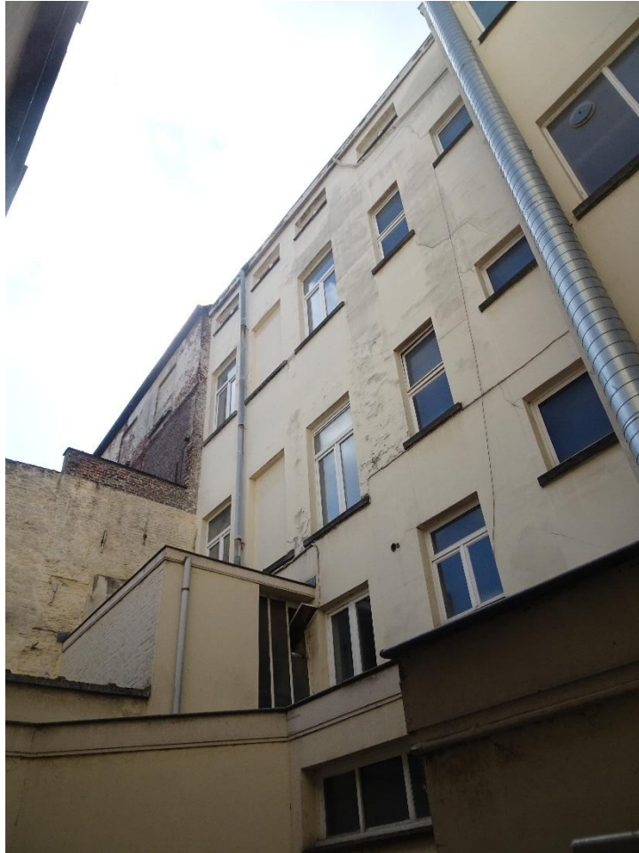
Figuur 11: Zicht op de percelen gelegen aan de Schouwburgstraat vanuit het noordwesten (Hofke ter Musse 2026)
