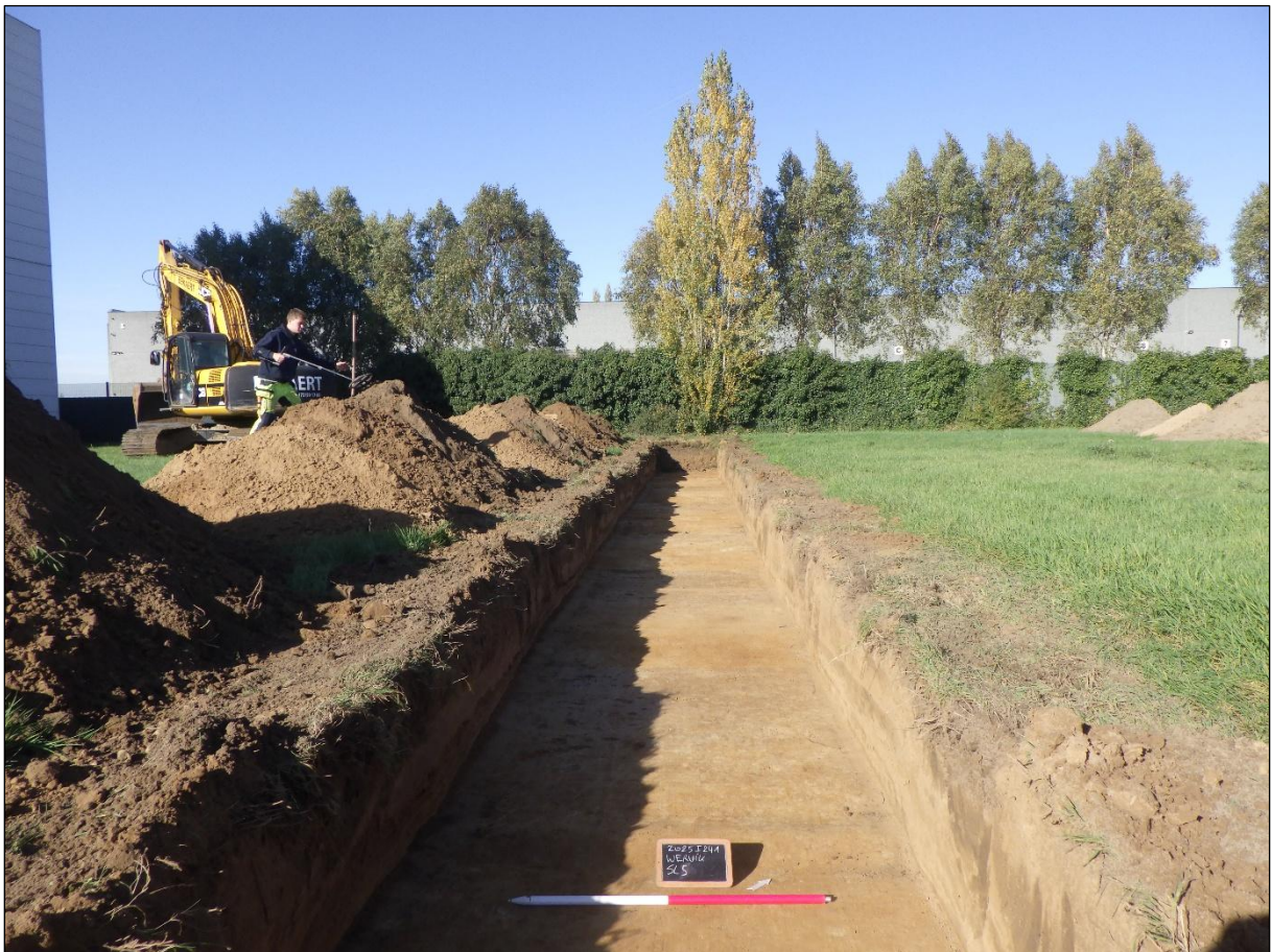
Figuur 6 Zicht op sleuf 5 met links metaaldetectie van de storthopen.
