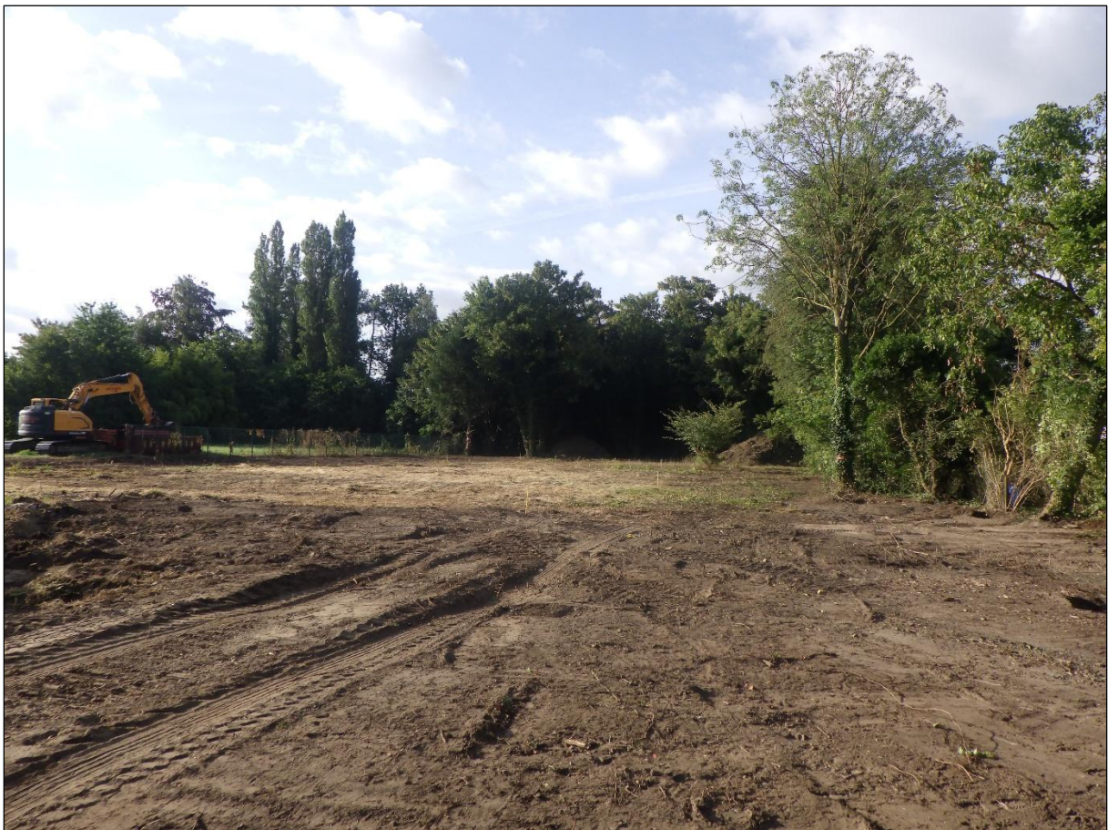
Figuur 4 Zicht op het zuidelijke deel van het plangebied voor de aanvang van het proefsleuvenonderzoek.
