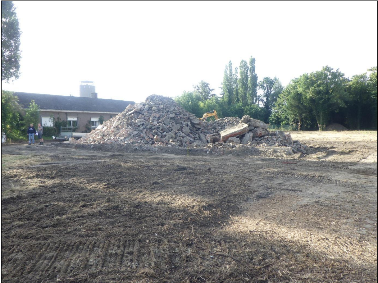
Figuur 5 Zicht op de gesloopte villa. Het puin bevindt zich in een kelder die als verstoorde zone opgetekend kon worden.
