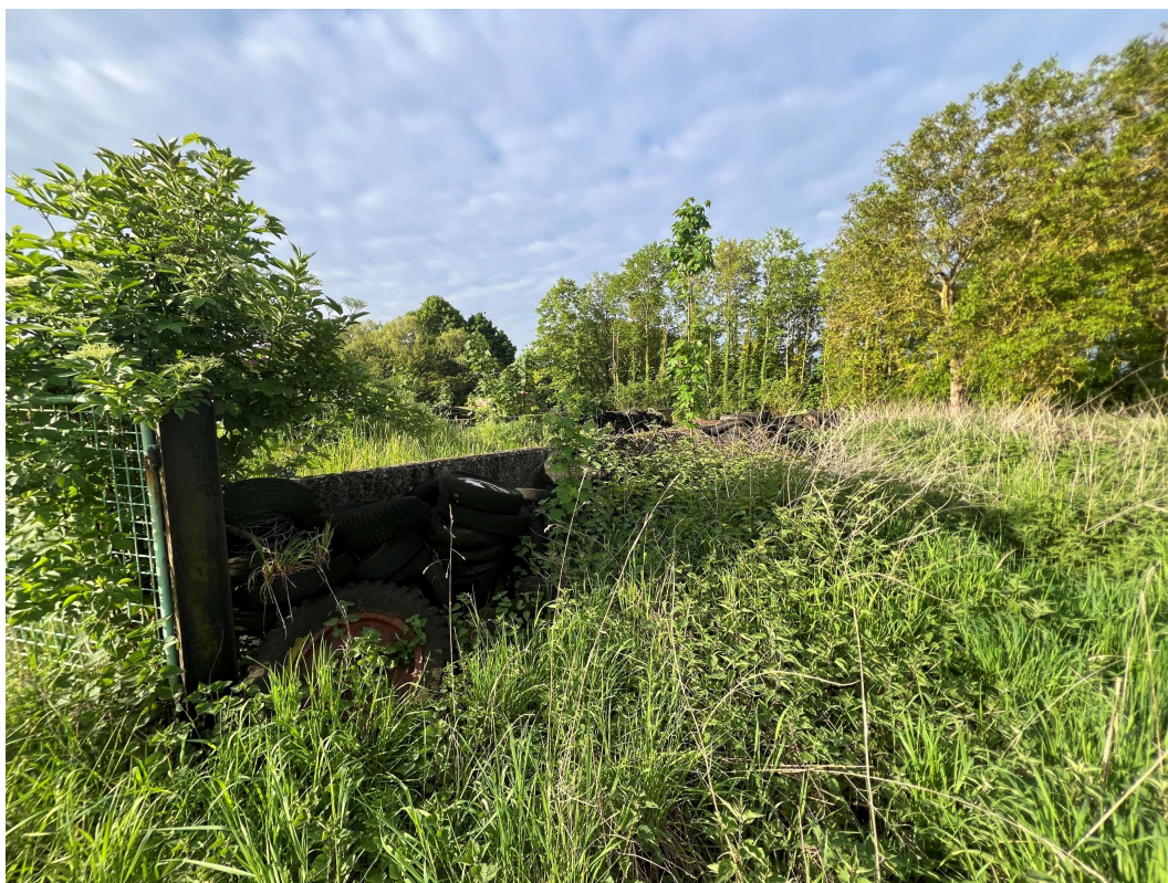
Fig. 3.10: Zicht op de verhardingen in het oosten van het terrein, in zuidelijke richting.
