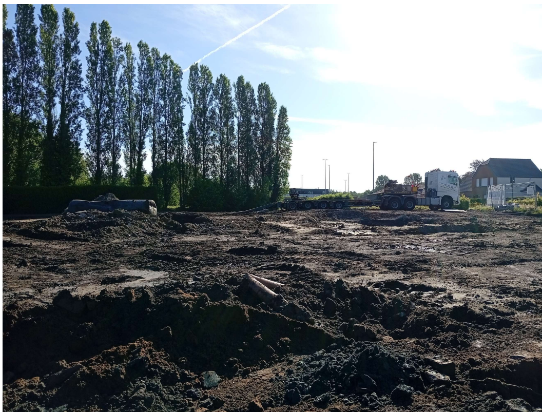
Fig. 3.8: Zicht op het onderzoeksgebied vanuit de noordwestelijke hoek.
