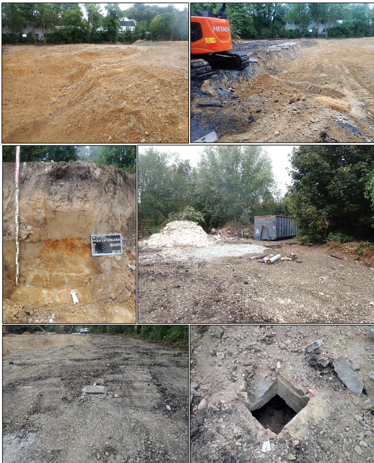
Figuur 7: Foto's van de centrale afgraving in het noorden van het plangebied (boven en links midden), de puinberg in het zuidwesten (midden rechts) en kelders en putten (onder) aangetroffen op het plangebied (©INDAR bv).
