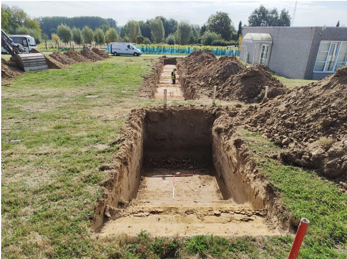
Figuur 46: Sleuf 4: onderbreking van de sleuf door de aanwezigheid van ijzeren palen.
