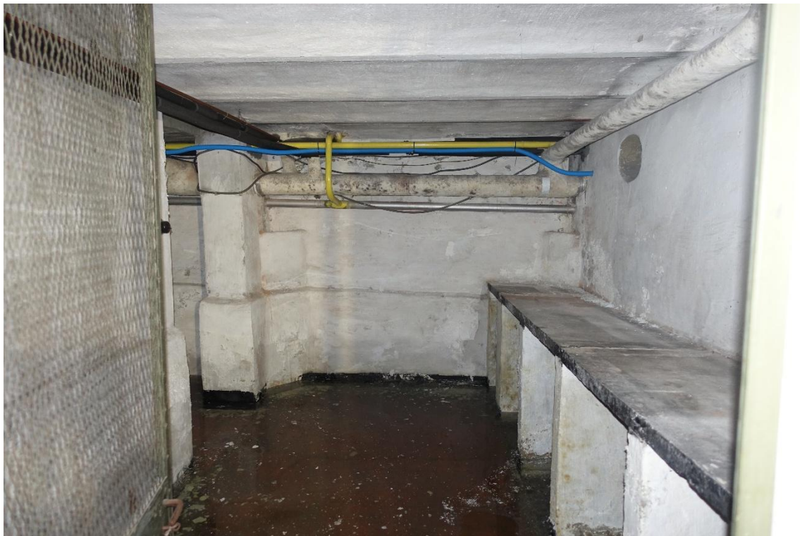
Figuur 3: Foto bestaande kelder
