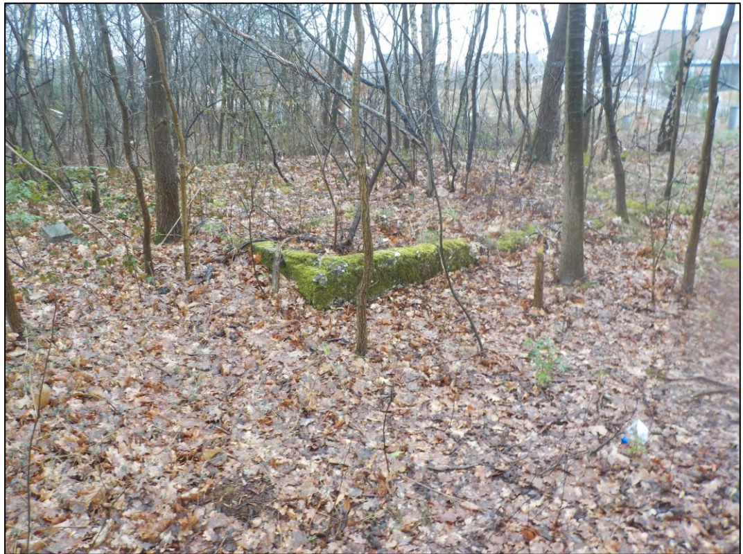
Afb. 29. Overzicht westelijke plangebied, er bevindt zich hier tussen boring 1 en 2 een ophoging met een betonnen fundament van een voormalige schuur.
