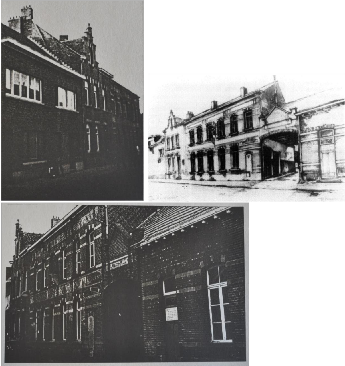
Figuur 50: Twee foto's bijgesloten bij de sloopaanvraag betreffende de bebouwing in de Peperstraat, (1991). 108
