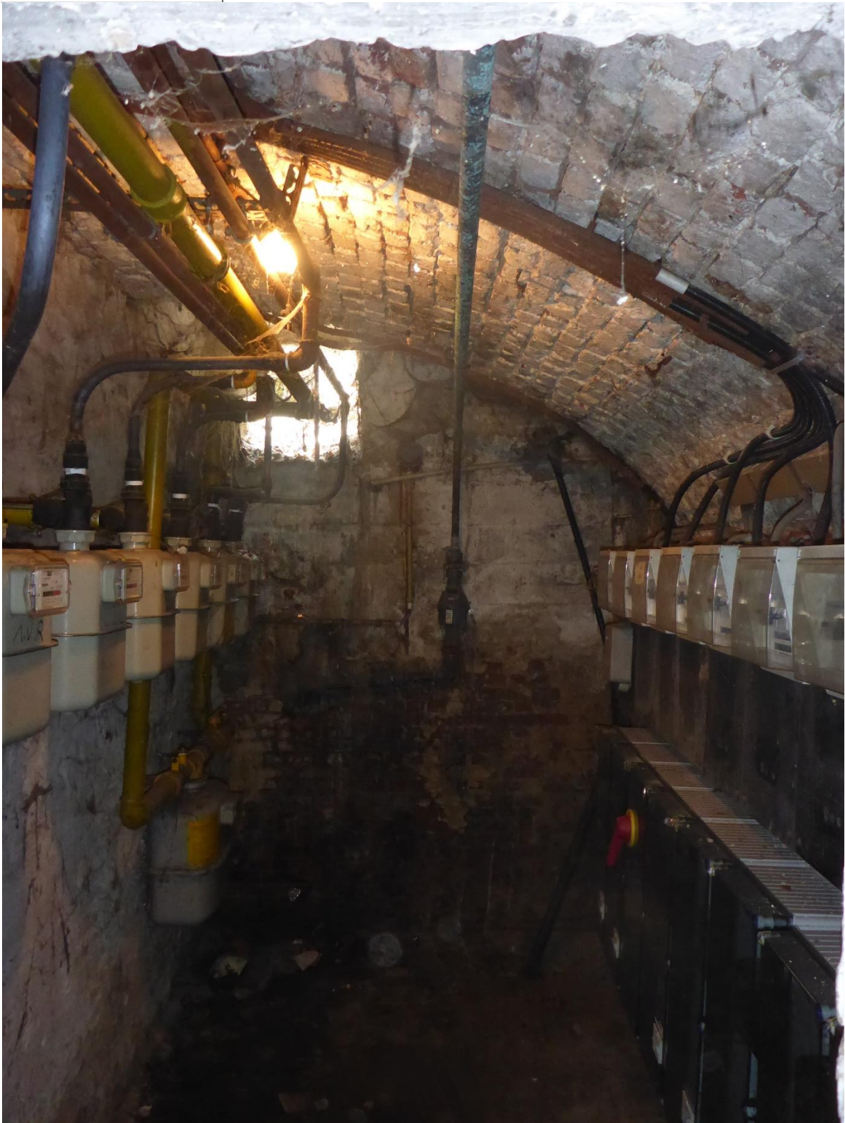
Figuur 36: Bakstenen tongewelf in de kelder onder huisnummer 11
