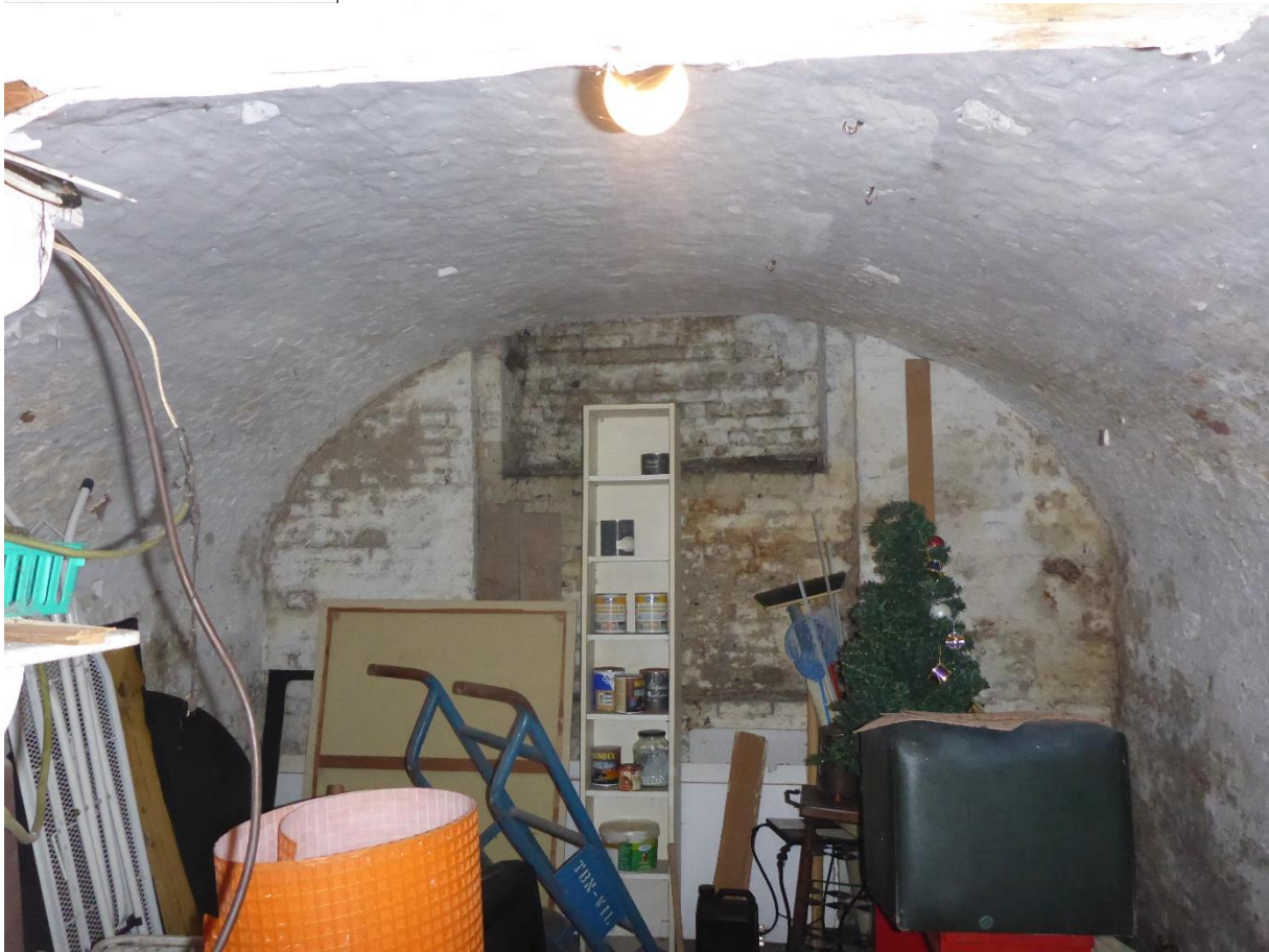
Figuur 35: Kelder huisnummer 7: achterzijde met bakstenen tongewelf
