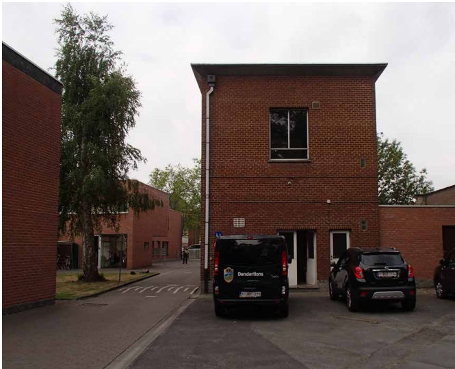
Figuur 10: Te slopen bebouwing
