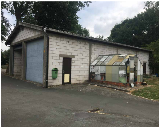
Figuur 12: Te slopen garage
