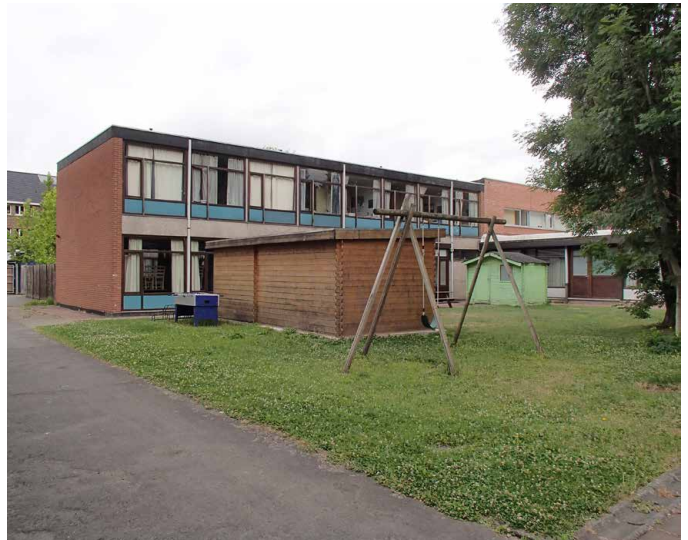
Figuur 11: Te slopen bebouwing
