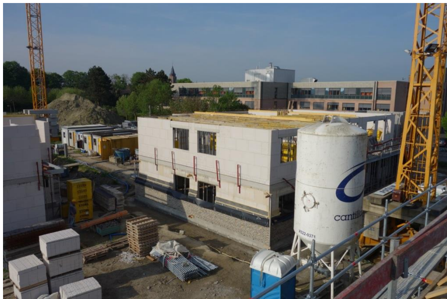
Figuur 24: Zicht op de bouwwerf en de locatie van de nieuwe wegnis (richting zuidwest)
