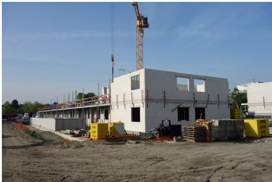
Figuur 22: Zicht op de bouwwerf en de locatie van de nieuwe wegenis (richting zuidwest)
