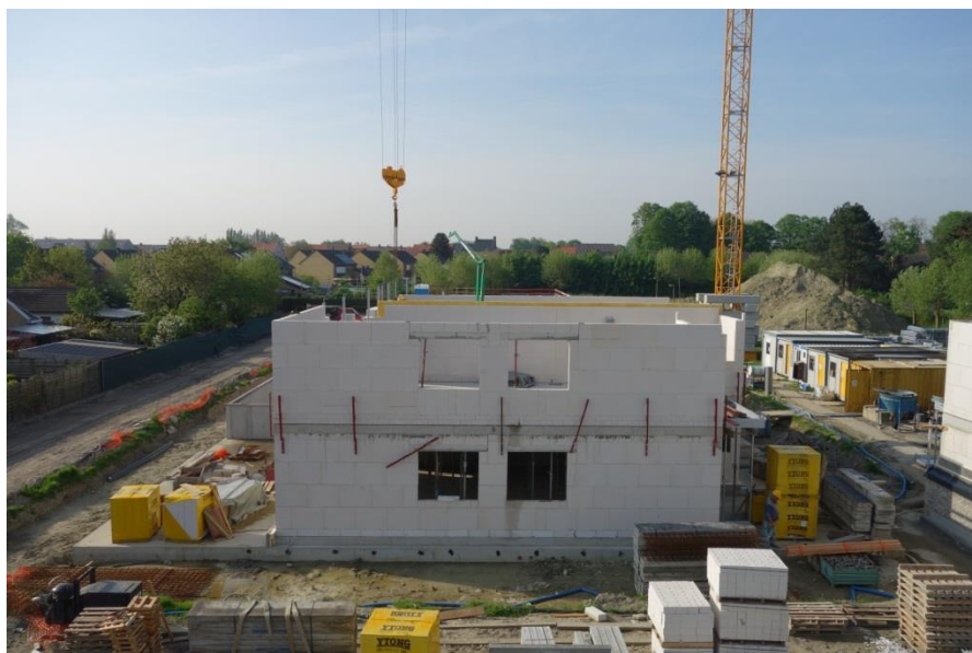
Figuur 23: Zicht op de bouwwerf en de locatie van de nieuwe wegenis (richting zuid)
