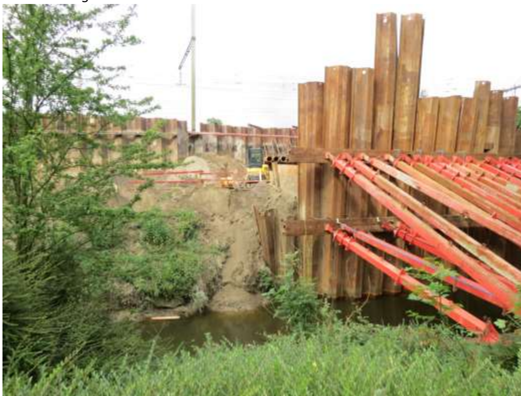
Figuur 22: werkzaamheden in het kader van fase 2b. Eigen opname, dd. 1/07/2016.
