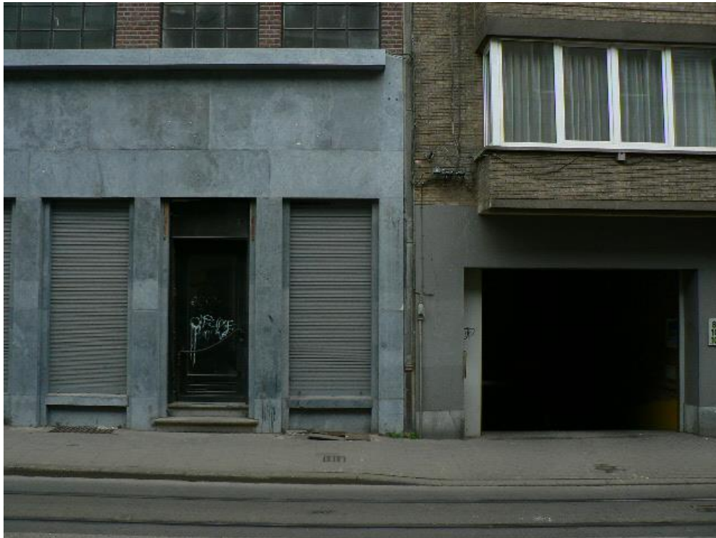
Figuur 4: zicht op bestaande gebouwen langs de Kortrijksepoortstraat. Rechts de toegang tot de niveau -1 en de bestaande garage
