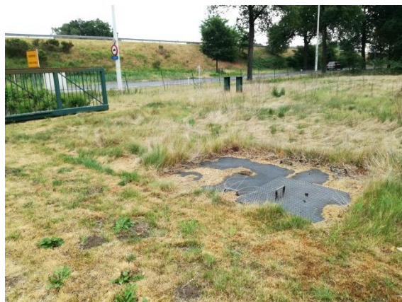
Figuur 10: Foto 4: Zicht op het rooster van ondergrondse putten (ARCHEBO bvba, 27/06/2017)
