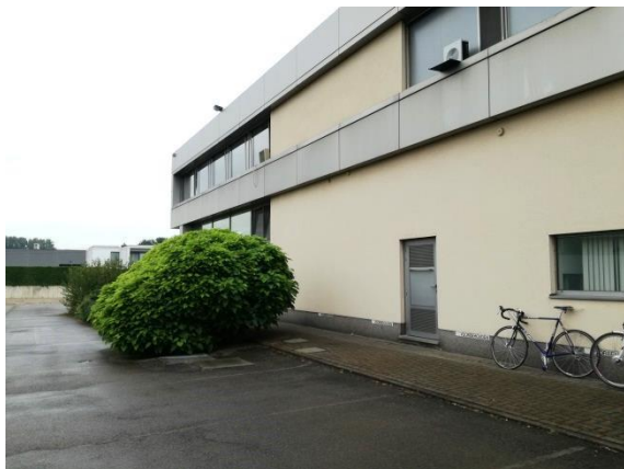
Figuur 13: Foto 7: Zicht op de achtergevel van het kantoorgebouw (ARCHEBO bvba, 27/06/2017)
