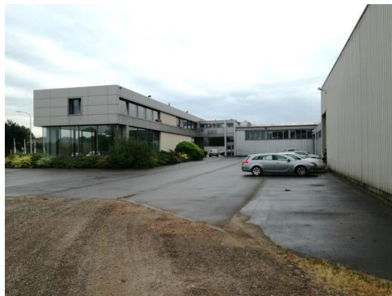
Figuur 14: Foto 8: Zicht op de achtergevel van het kantoorgebouw en de bedrijfshallen (ARCHEBO bvba, 27/06/2017)
