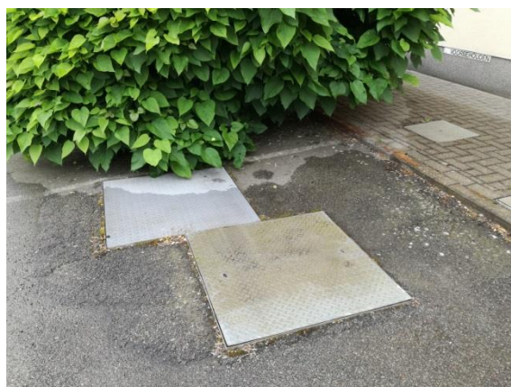
Figuur 12: Foto 6: Zicht op het rooster van ondergrondse putten (ARCHEBO bvba, 27/06/2017)
