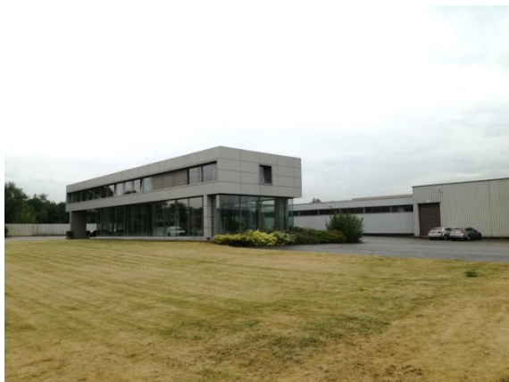
Figuur 7: Foto 1: Zicht op het kantoorgebouw en de bedrijfshallen (ARCHEBO bvba, 27/06/2017)
