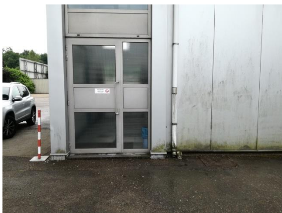
Figuur 11: Foto 5: Zicht op het rooster van ondergrondse riolering (ARCHEBO bvba, 27/06/2017)
