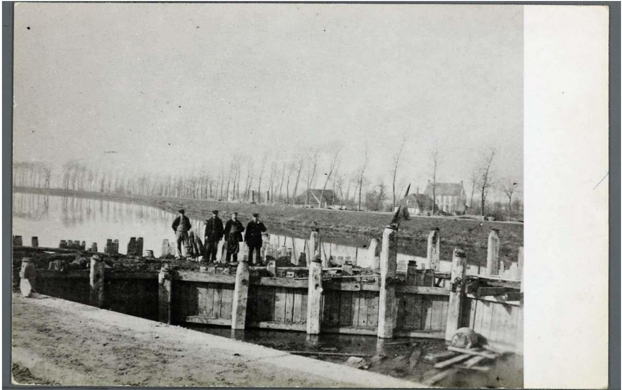
Figuur 12: Uitgraven van een afleidingskanaal aan de Houtkaai te Sint-Pieters-op-den-Dijk, Kasteel Ruddershove op de achtergrond (erfgoedbrugge.be)
