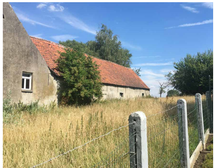
Figuur 12: Af te breken stalstructuren vanuit het zuiden
